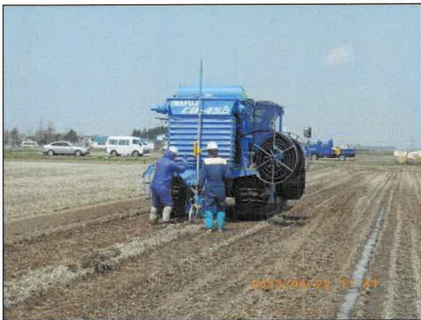
工 種：吸水渠工 写真説明：吸水管引込み状況
