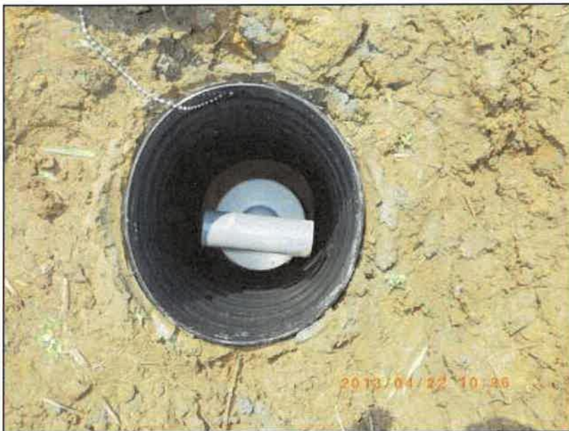
工 種：水閘工 写真説明：水閘布設完了
