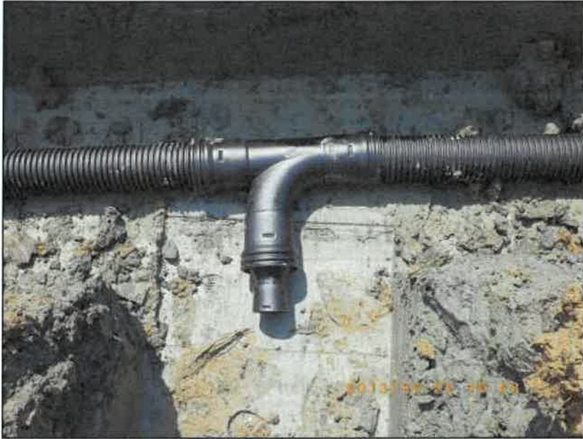
工 種：集水渠工 写真説明：部分拡大
