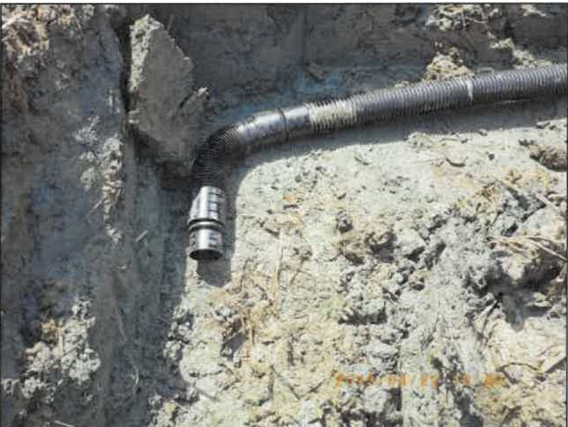
工 種：集水渠工 写真説明：部分拡大
