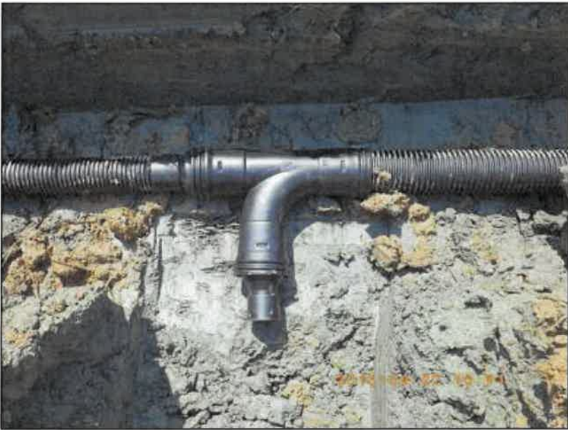
工 種：集水渠工 写真説明：部分拡大
