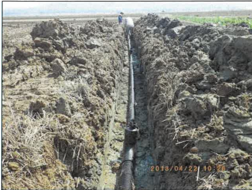
工 種：集水渠工 写真説明：集水管布設状況
