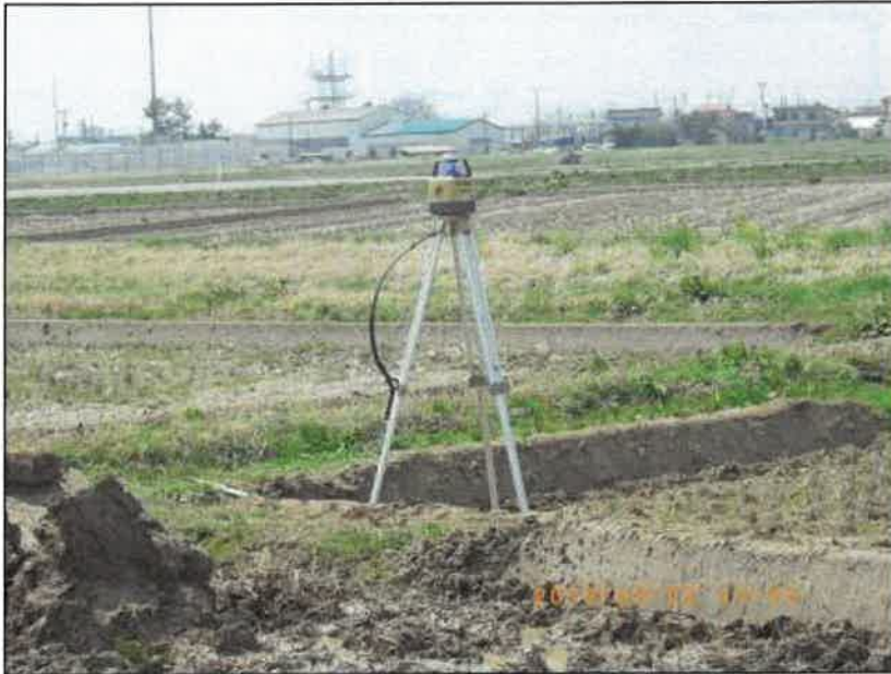
工 種：吸水渠工 写真説明：レーザーレベル設置状況
