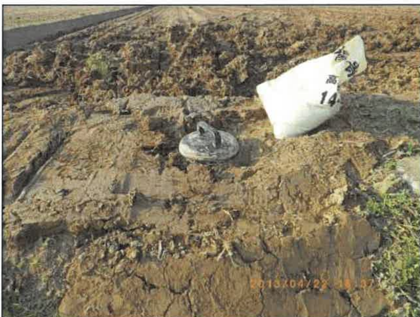
工 種：水閘工 写真説明：埋戻し完了
