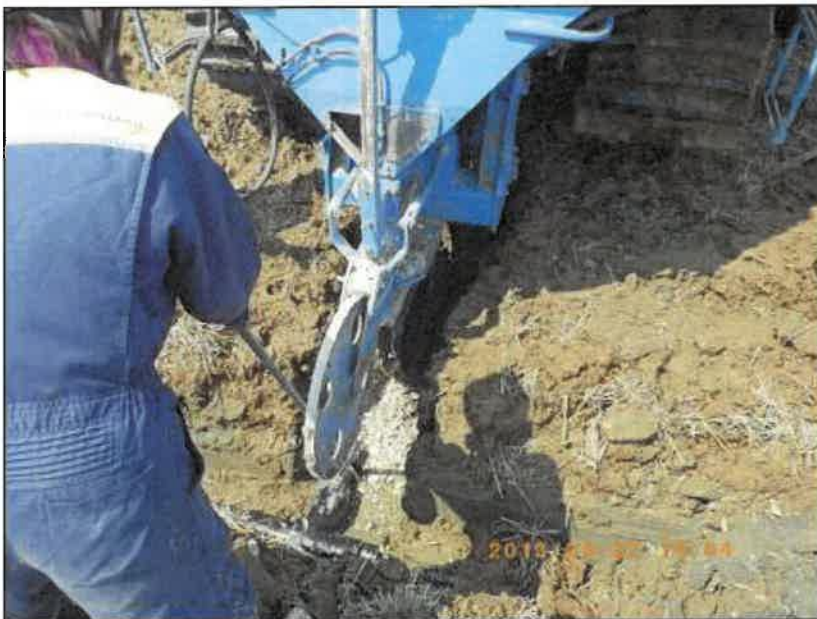
工 種：吸水渠工 写真説明：吸水渠接続状況
