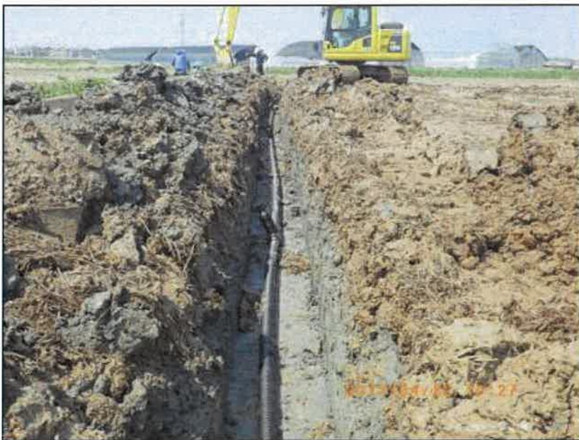
工 種：集水渠工 写真説明：集水管布設完了
