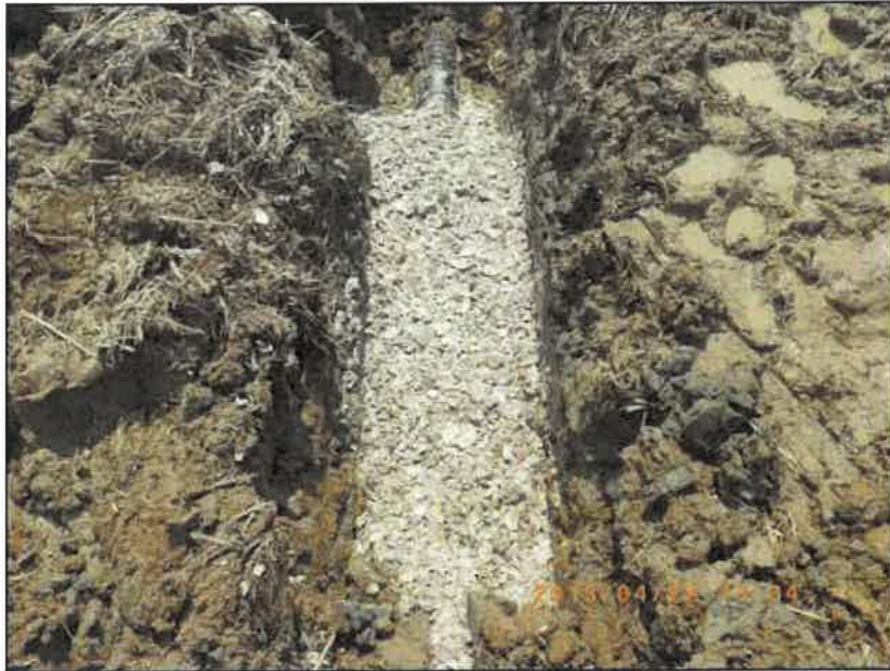
工 種：吸水渠工 写真説明：被覆材投入完了
