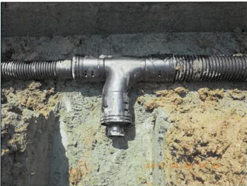
工 種：集水渠工 写真説明：部分拡大
