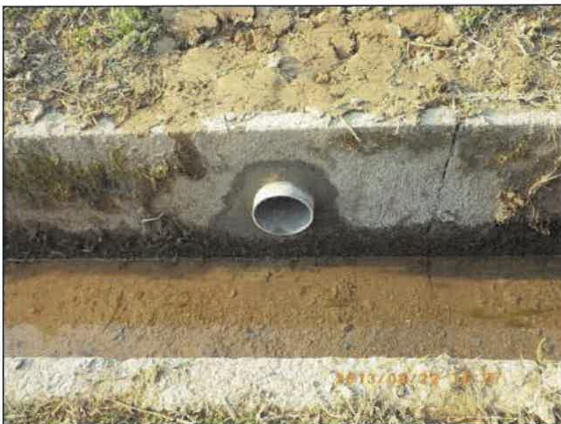
工 種：水閘工 写真説明：管口仕上り完了
