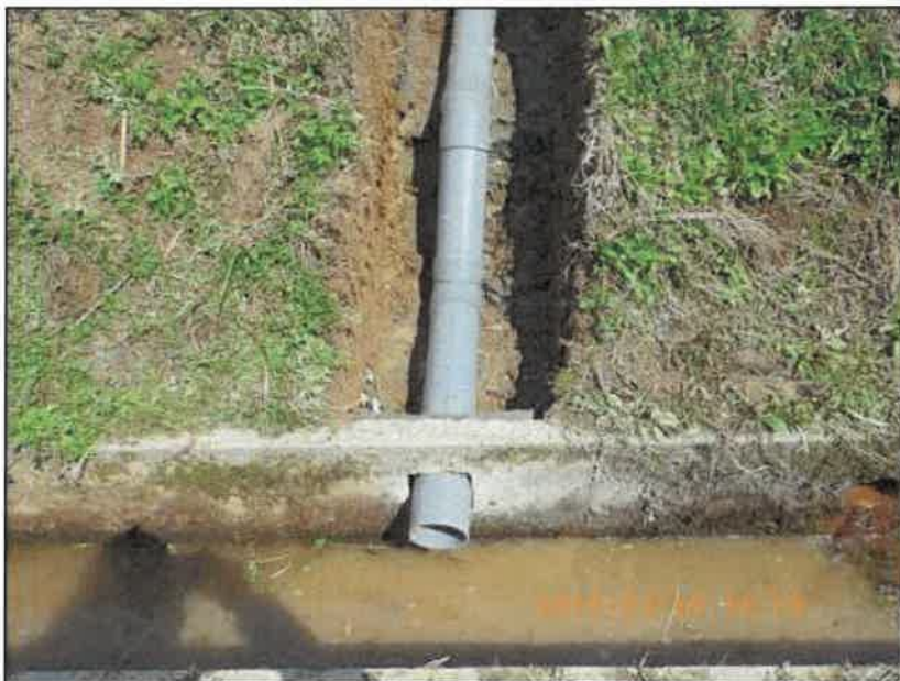
工 種：水閘工 写真説明：水閘布設完了
