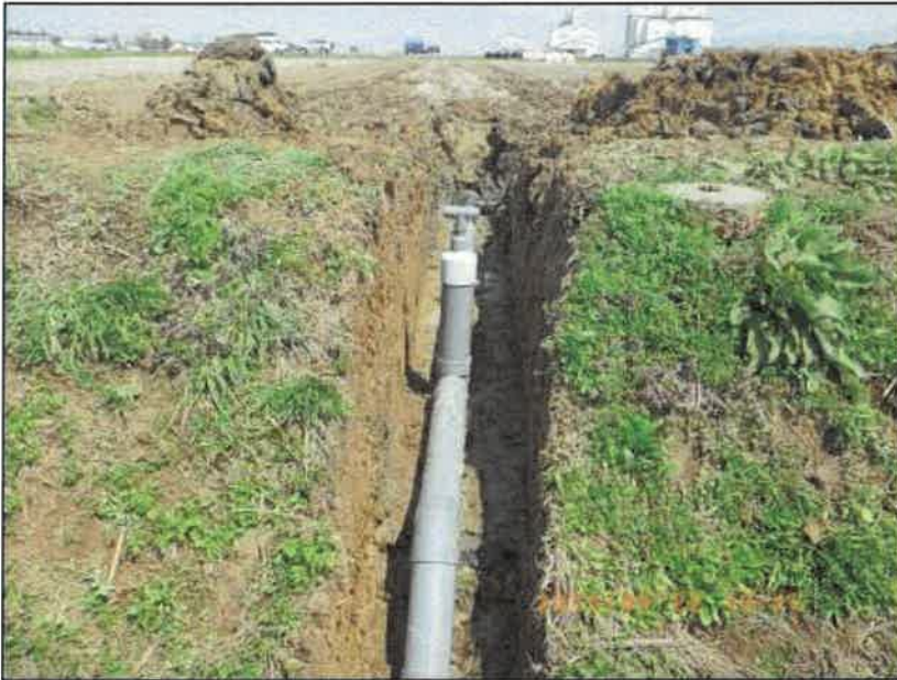
工 種：水閘工 写真説明：水閘布設完了
