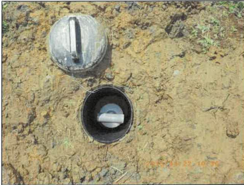
工 種：水閘工 写真説明：水閘布設完了
