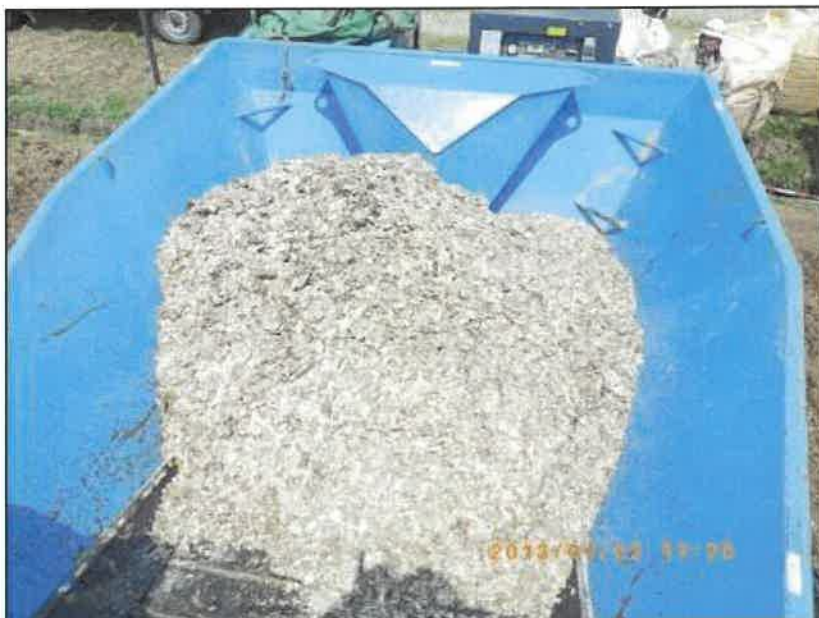
工 種：吸水渠工 写真説明：被覆材
