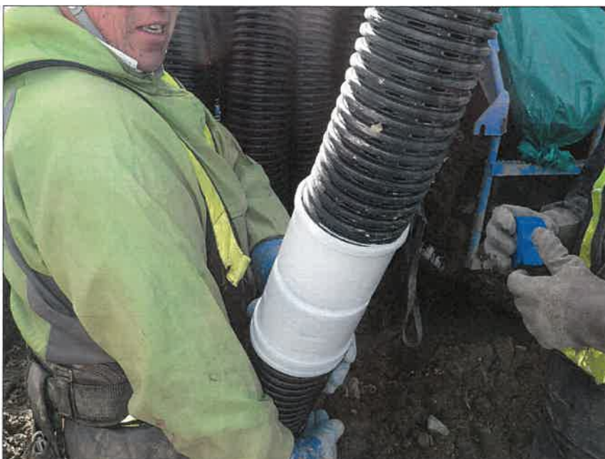
写真区分:施工状況写真 工種:2工区 田番 104-3 種別:吸水渠状況 写真タイトル:ロール管接続 差し込み状況
