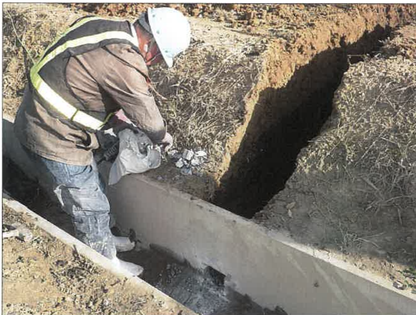
写真区分:施工状況写真 工種:2工区 田番 104-3 種別:水閘工状況 写真タイトル:ハツリ片処理 状況
