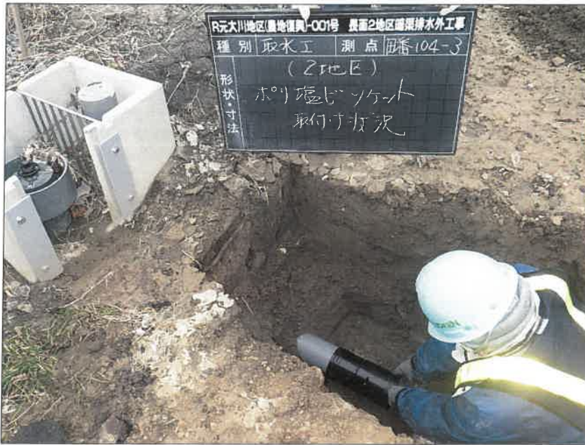
写真区分:施工状況写真 工種:2工区 田番 104-3 種別:取水工状況 写真タイトル:ポリ塩ビソケット取付
