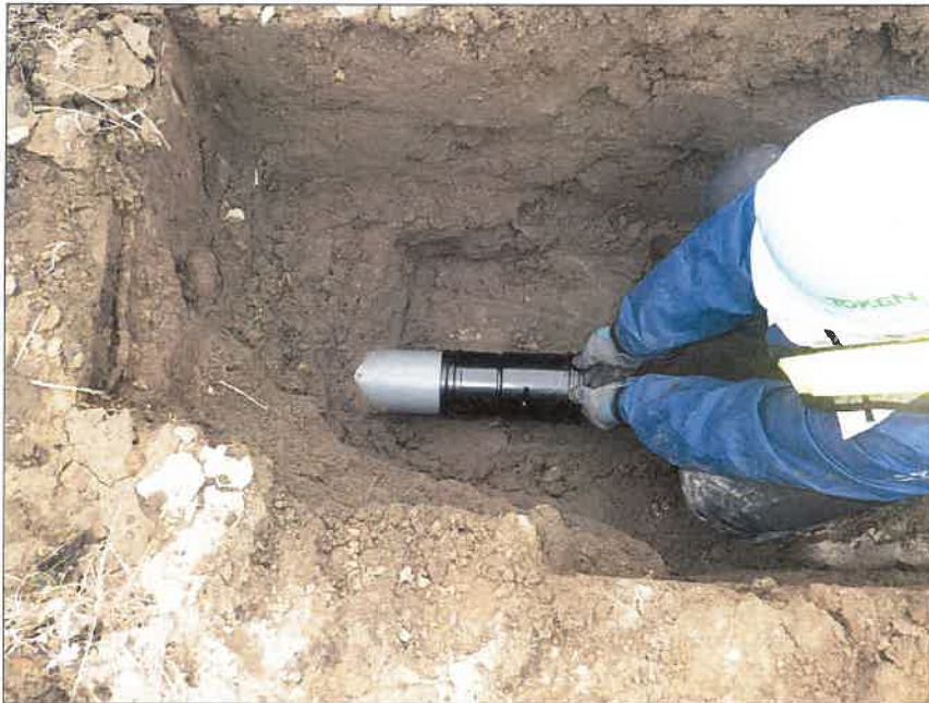
写真区分:施工状況写真 工種:2工区 田番 104-3 種別:取水工状況 写真タイトル:ポリ塩ビソケット取付
