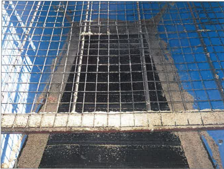
写真区分: 施工状況写真 工種: 2工区 田番 104-3 種別: 吸水渠状況 写真タイトル: モミガラ積込 み前ホッパー内確認
