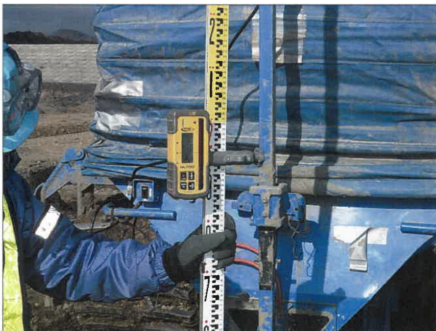
写真区分: 施工状況写真 工種: 2工区 田番 104-3 種別: 吸水渠状況 写真タイトル: 接続部布設高 測定状況
