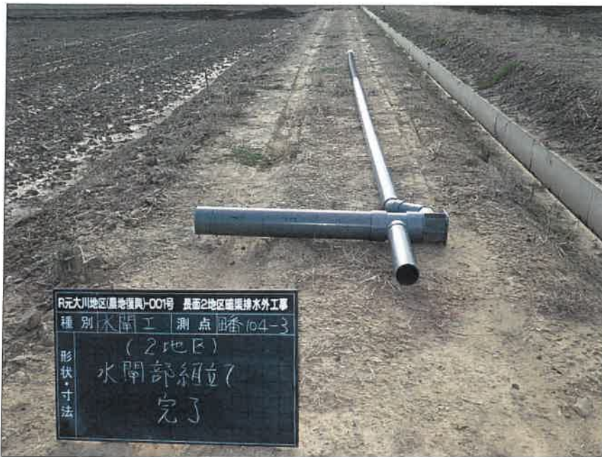
写真区分:施工状況写真 工種:2工区 田番 104-3 種別:水閘工状況 写真タイトル:水閘部組立完了
