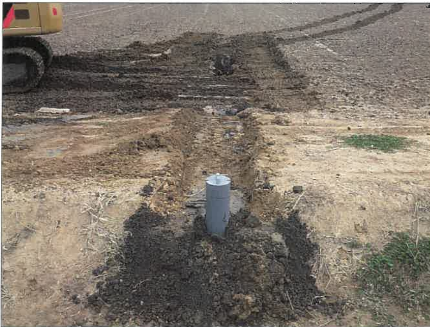
写真区分: 施工状況写真 工種: 2工区 田番 104-3 種別: 水閘工状況 写真タイトル: 埋戻し及び人 カタコ転圧完了
