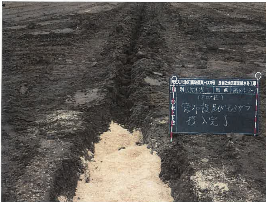
写真区分:施工状況写真 工種:2工区 田番 104-3 種別:吸水渠状況 写真タイトル:管布設.モミ ガラ投入完了
