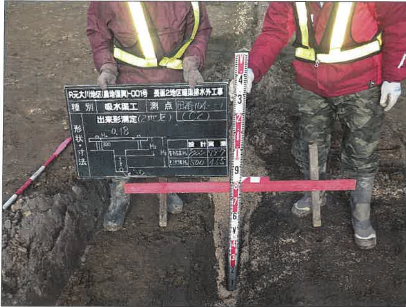
写真区分: 施工状況写真 工種: 2工区 田番 104-3 種別: 吸水渠出来形 写真タイトル: 管布設高出来形 (C2)
