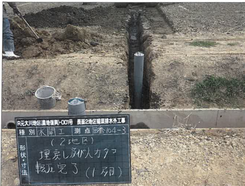
写真区分: 施工状況写真 工種: 2工区 田番 104-3 種別: 水閘工状況 写真タイトル: 埋戻し及び人カヲコ転圧完了
