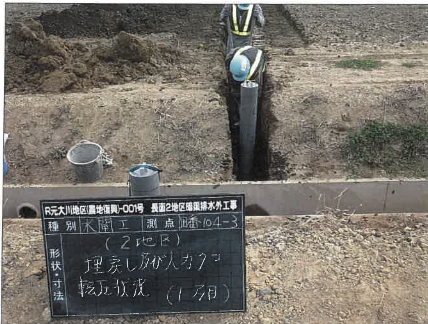
写真区分:施工状況写真 工種:2工区 田番 104-3 種別:水閘工状況 写真タイトル:埋戻し及び人 カヲコ転圧状況
