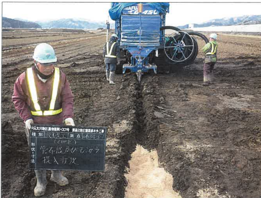
写真区分:施工状況写真 工種:2工区 田番 104-3 種別:吸水渠状況 写真タイトル:管布設.モミ ガラ投入状況
