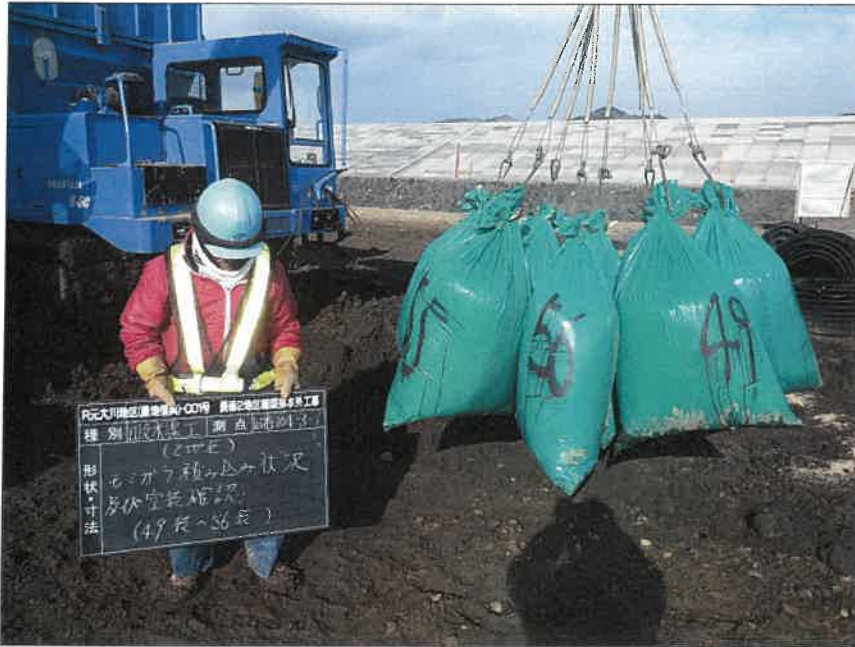
写真区分: 施工状況写真 工種: 2工区 田番 104-3 種別: 吸水渠状況 写真タイトル: モミガラ積込み状況
