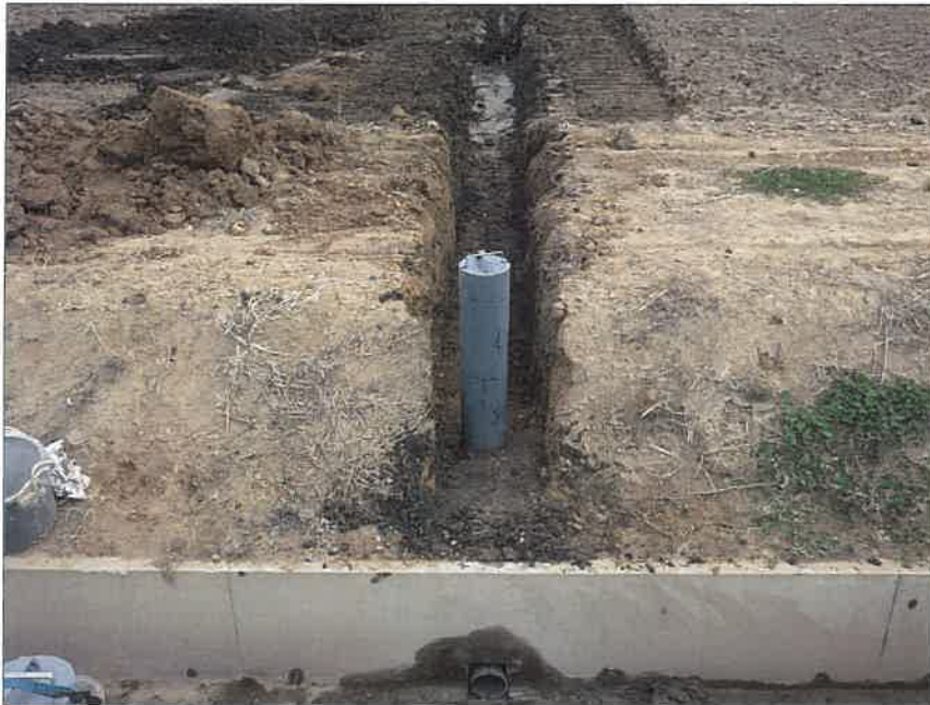
写真区分: 施工状況写真 工種: 2工区 田番 104-3 種別: 水閘工状況 写真タイトル: 埋戻し及び人 力タコ転圧完了
