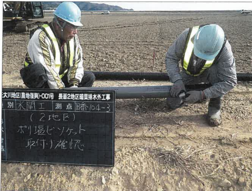
写真区分:施工状況写真 工種:2工区 田番 104-3 種別:水閘工状況 写真タイトル:ポリ塩ビソケット取付
