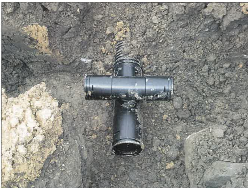
写真区分:施工状況写真 工種:2工区 田番 104-3 種別:水閘工状況 写真タイトル:立体十字管取付
