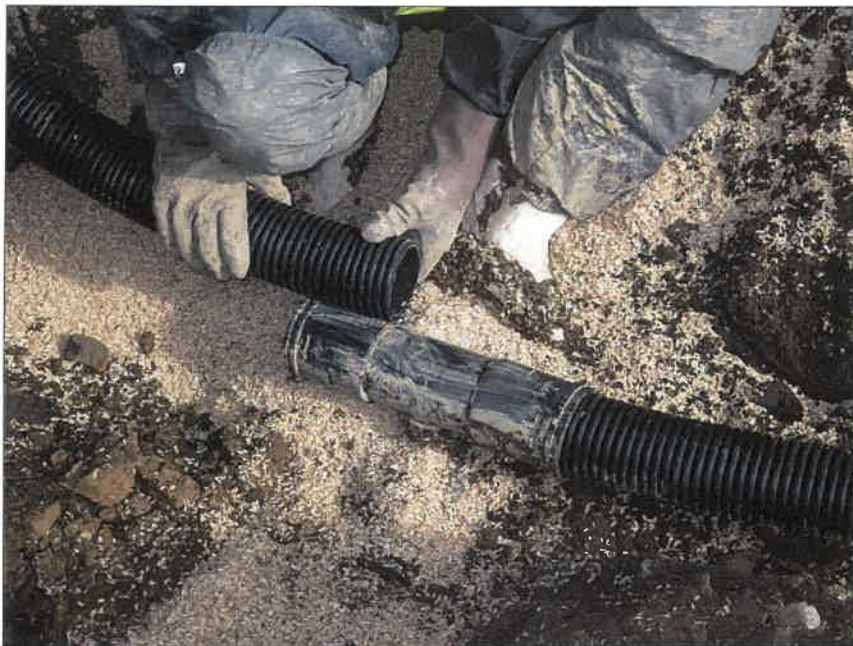
写真区分:施工状況写真 工種:2工区 田番 104-3 種別:吸水渠状況 写真タイトル:十字管部管接 続状況
