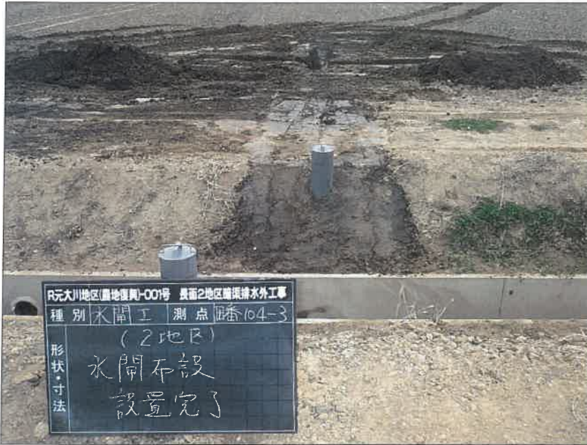
写真区分:施工状況写真 工種:2工区 田番 104-3 種別:水閘工状況 写真タイトル:水閘部布設完了
