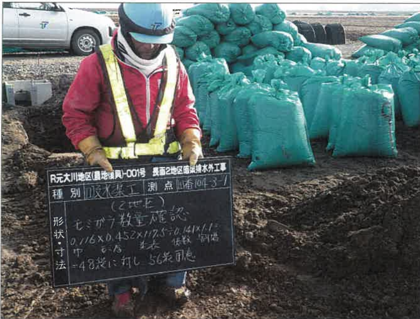
写真区分:施工状況写真 工種:2工区 田番 104-3 種別:吸水渠状況 写真タイトル:モミガラ積込み数量確認
