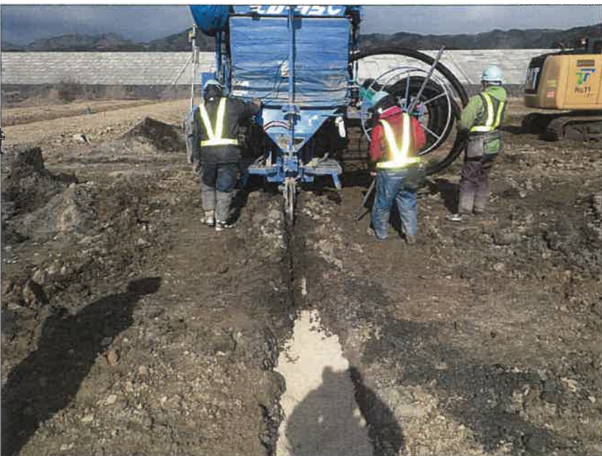
写真区分: 施工状況写真 工種: 2工区 田番 104-3 種別: 吸水渠状況 写真タイトル: 接続部管布設モミガラ投入状況
