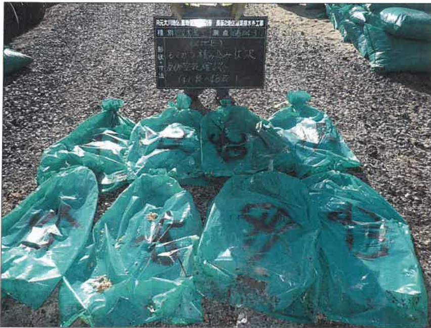
写真区分: 施工状況写真 工種: 2工区 田番 104-3 種別: 吸水渠状況 写真タイトル: モミガラ積込み後空袋確認
