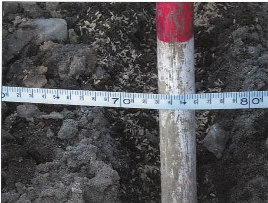
写真区分:施工状況写真 工種:2工区 田番 104-3 種別:吸水渠状況 写真タイトル:間隔測定状況
