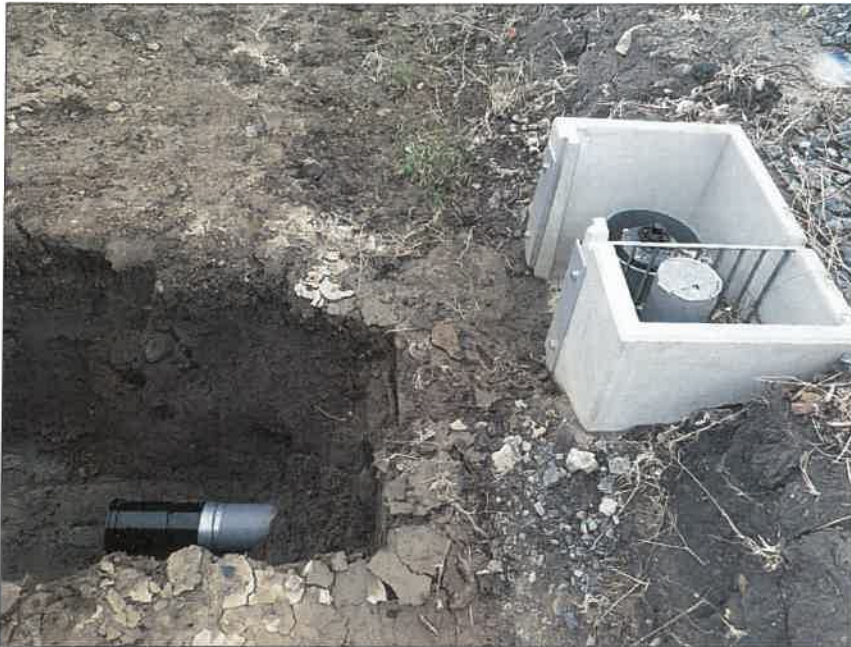
写真区分:施工状況写真 工種:2工区 田番 104-3 種別:取水工状況 写真タイトル:取水工部布設完了
