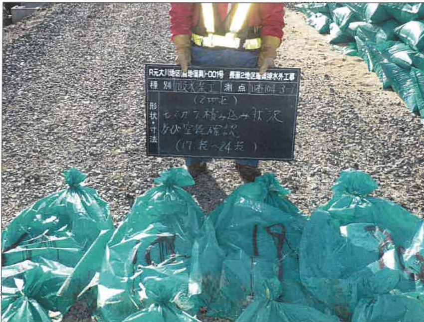
写真区分:施工状況写真 工種:2工区 田番 104-3 種別:吸水渠状況 写真タイトル:モミガラ積み み後空袋確認
