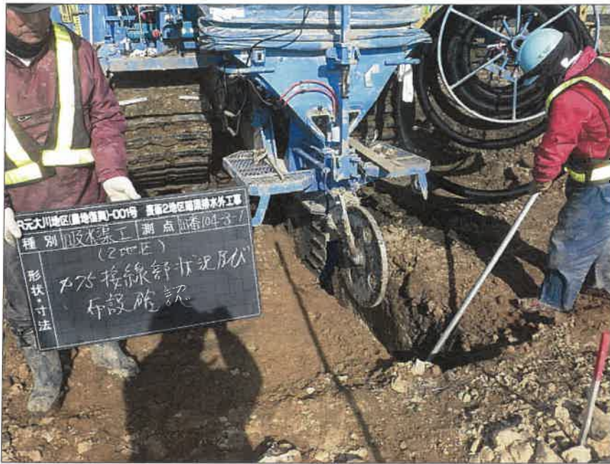
写真区分: 施工状況写真 工種: 2工区 田番 104-3 種別: 吸水渠状況 写真タイトル: 接続部管接続 状況
