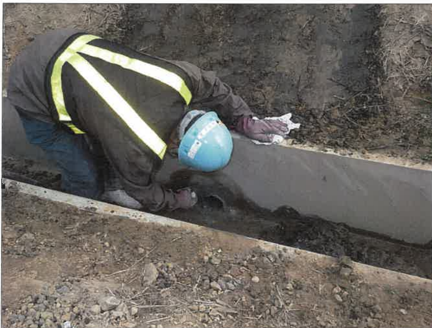
写真区分:施工状況写真 工種:2工区 田番 104-3 種別:水閘工状況 写真タイトル:吐口部モルタル 仕上げ状況
