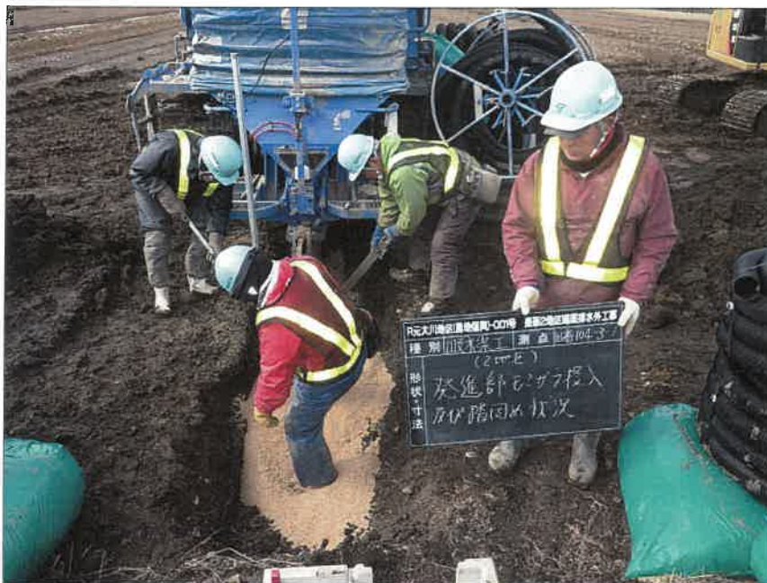
写真区分:施工状況写真 工種:2工区 田番 104-3 種別:吸水渠状況 写真タイトル:発進部モミガラ投入踏み固め状況
