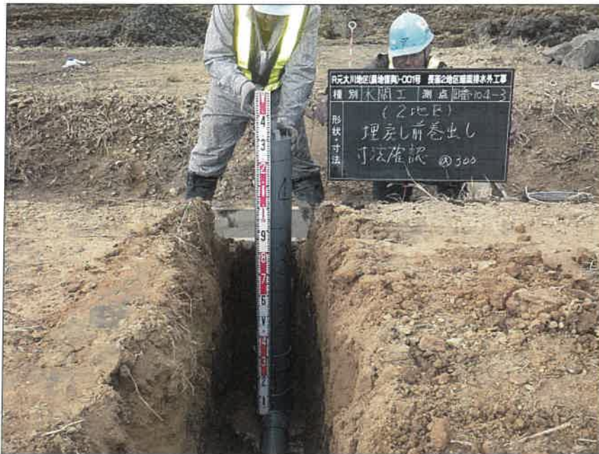
写真区分:施工状況写真 工種:2工区 田番 104-3 種別:水閘工状況 写真タイトル:埋戻し前巻き 出し確認
