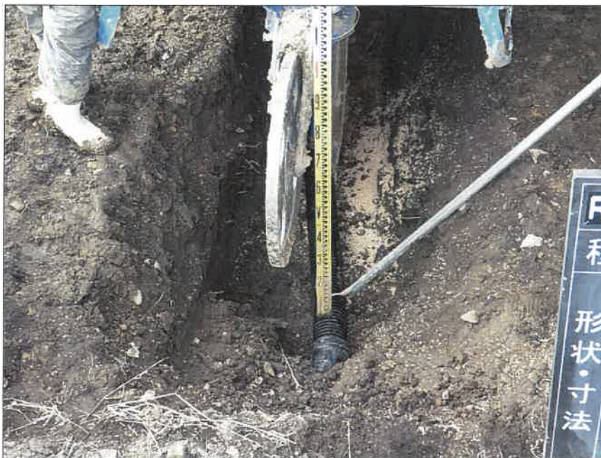
写真区分:施工状況写真 工種:2工区 田番 104-3 種別:吸水渠状況 写真タイトル:発進部管布設 高確認状況
