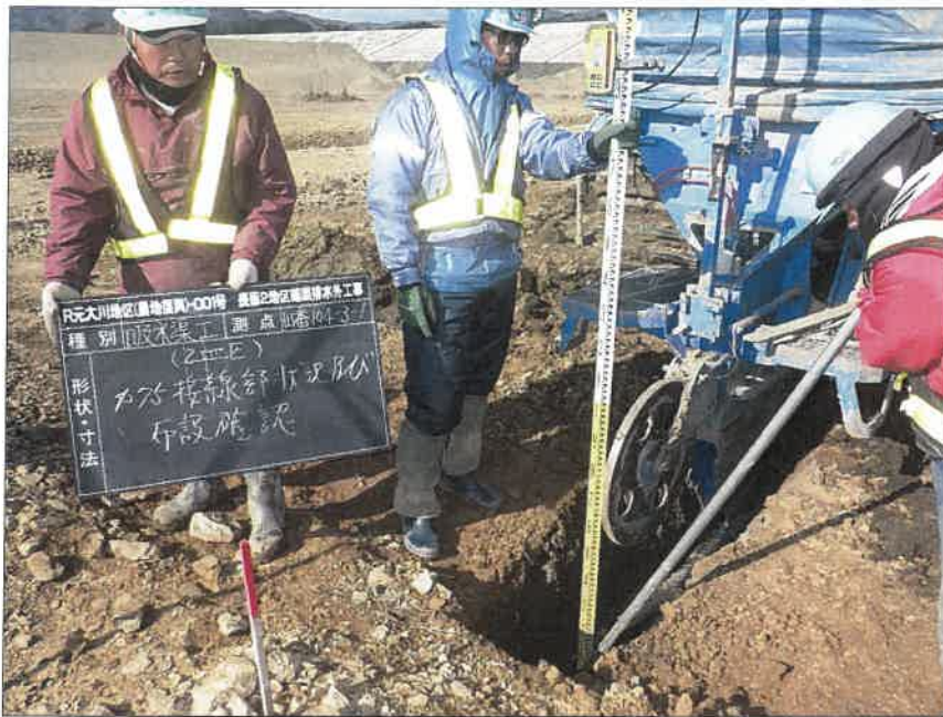
写真区分: 施工状況写真 工種: 2工区 田番 104-3 種別: 吸水渠状況 写真タイトル: 接続部布設高 測定状況
