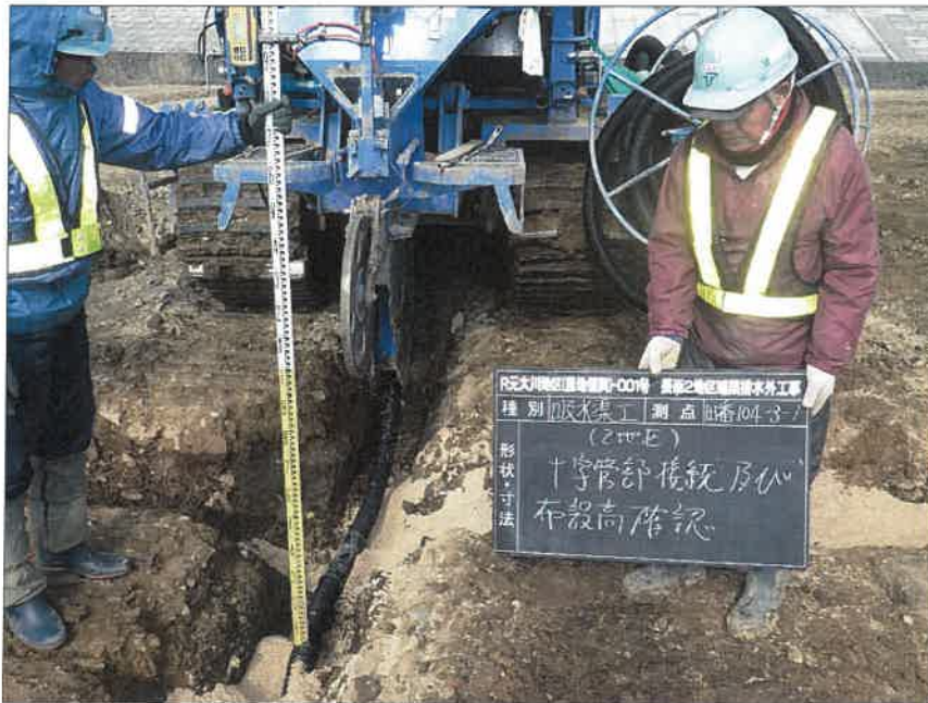
写真区分:施工状況写真 工種:2工区 田番 104-3 種別:吸水渠状況 写真タイトル:十字管部布設 高確認状況
