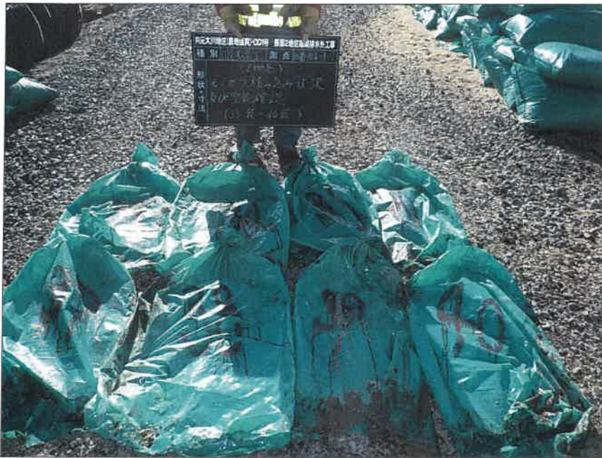
写真区分:施工状況写真 工種:2工区 田番 104-3 種別:吸水渠状況 写真タイトル:ゴミガラ積み 込み後空袋確認
