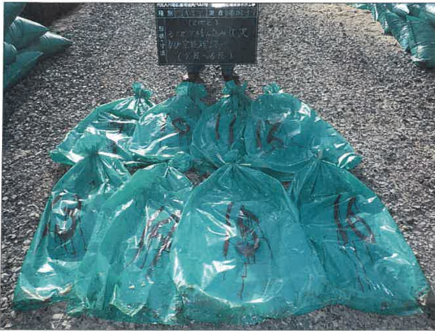
写真区分: 施工状況写真 工種: 2工区 田番 104-3 種別: 吸水渠状況 写真タイトル: モミガラ積込み後空袋確認
