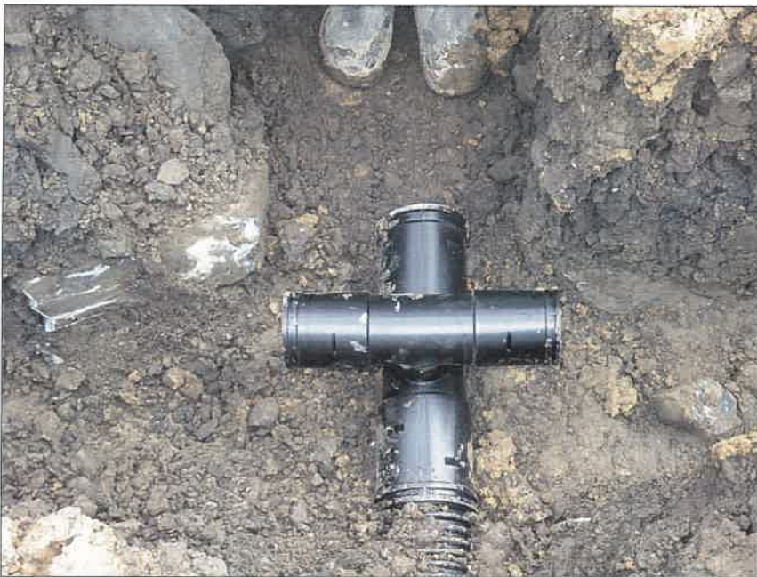
写真区分:施工状況写真 工種:2工区 田番 104-3 種別:水閘工状況 写真タイトル:立体十字管取付
