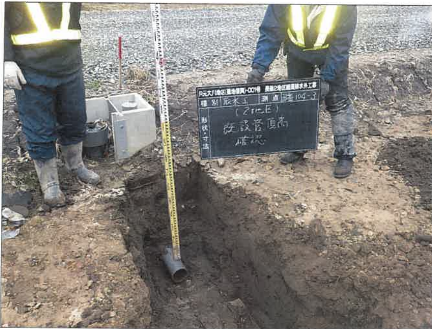
写真区分:施工状況写真 工種:2工区 田番 104-3 種別:取水工状況 写真タイトル:既設管頂高確認
