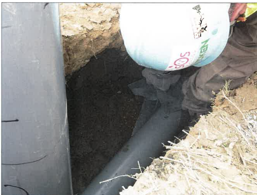
写真区分:施工状況写真 工種:2工区 田番 104-3 種別:水開工状況 写真タイトル:コーキングシート取付
