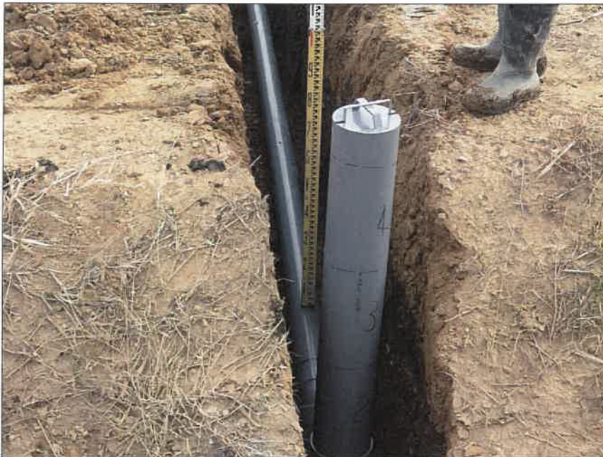
写真区分:施工状況写真 工種:2工区 田番 104-3 種別:水閘工状況 写真タイトル:水閘部設置高 確認
