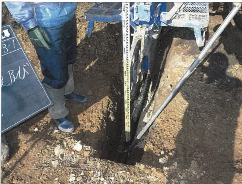
写真区分: 施工状況写真 工種: 2工区 田番 104-3 種別: 吸水渠状況 写真タイトル: 接続部布設高 測定状況
