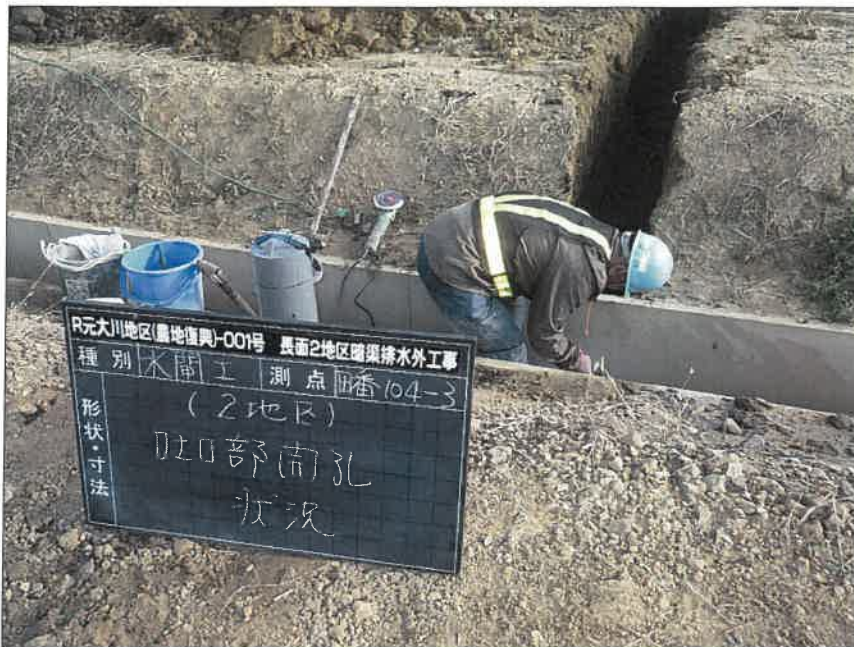
写真区分: 施工状況写真 工種: 2工区 田番 104-3 種別: 水閘工状況 写真タイトル: 吐け口開孔状況
