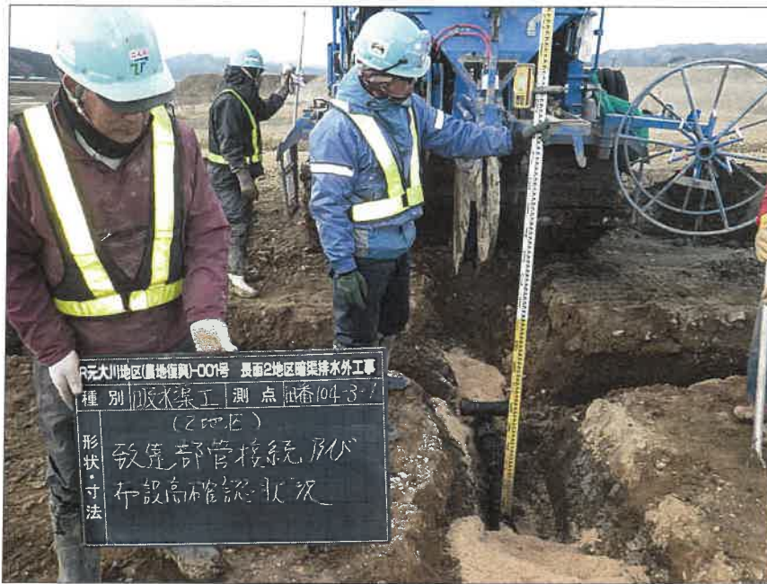
写真区分:施工状況写真 工種:2工区 田番 104-3 種別:吸水渠状況 写真タイトル:到達部管布設 高確認
