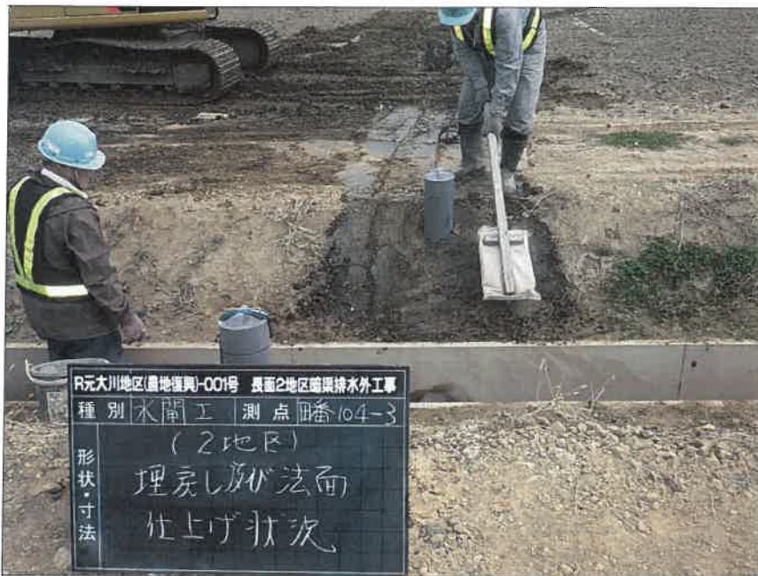
写真区分:施工状況写真 工種:2工区 田番 104-3 種別:水閘工状況 写真タイトル:埋戻し及び法 面仕上げ状況
