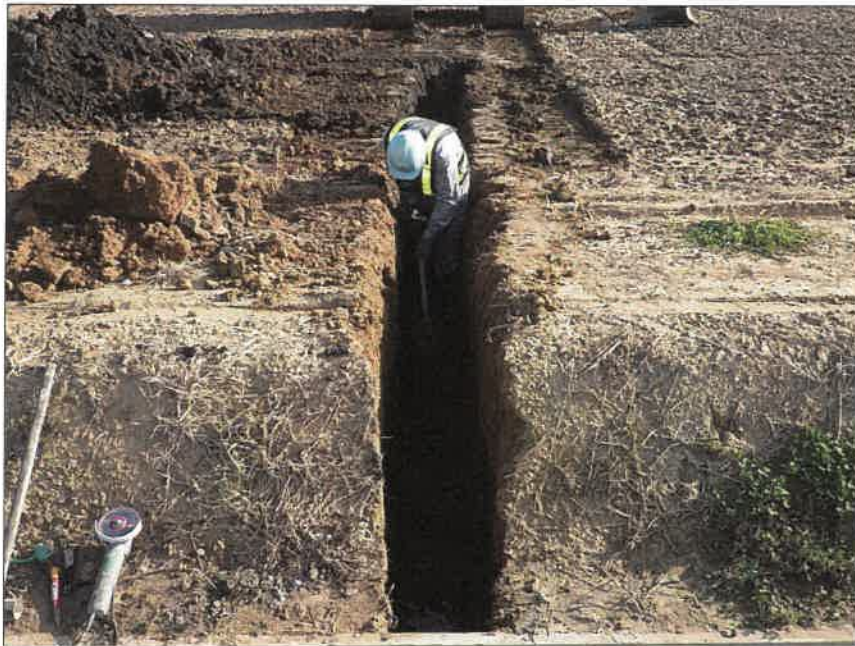
写真区分:施工状況写真 工種:2工区 田番 104-3 種別:水閘工状況 写真タイトル:床均し状況
