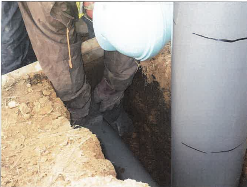
写真区分:施工状況写真 工種:2工区 田番 104-3 種別:水開工状況 写真タイトル:コーキングシート取付
