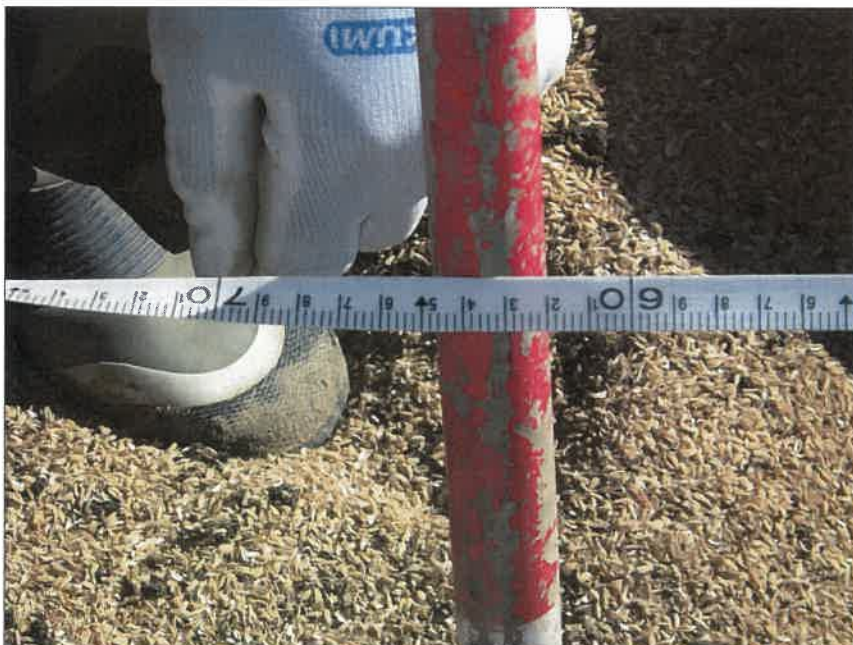
写真区分:施工状況写真 工種:2工区 田番 104-3 種別:吸水渠状況 写真タイトル:延長測定状況
