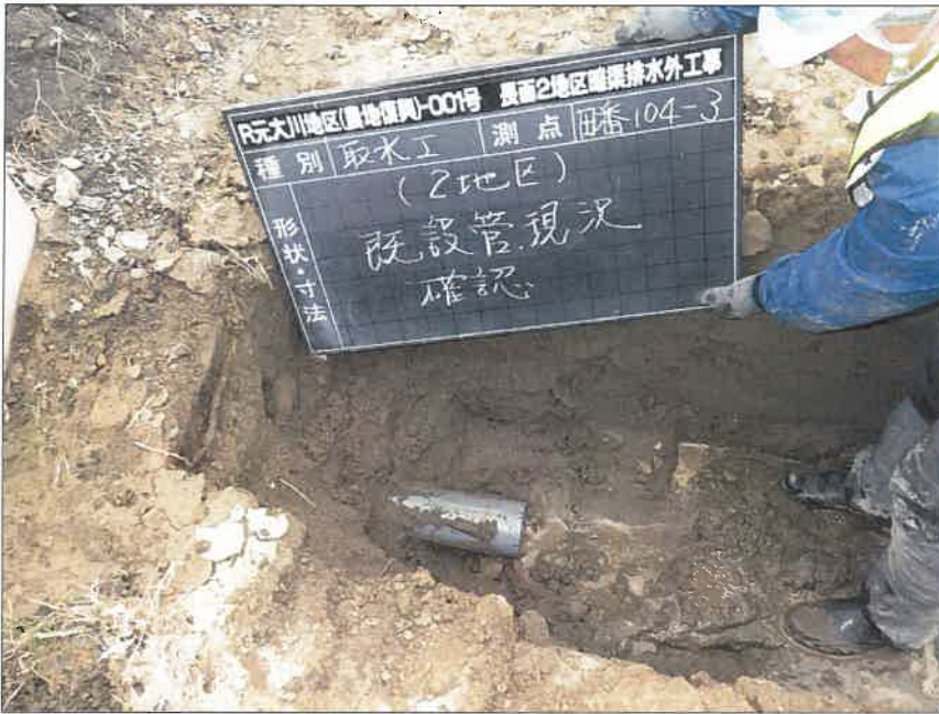
写真区分: 施工状況写真 工種: 2工区 田番 104-3 種別: 取水工状況 写真タイトル: 既設管現況確認
