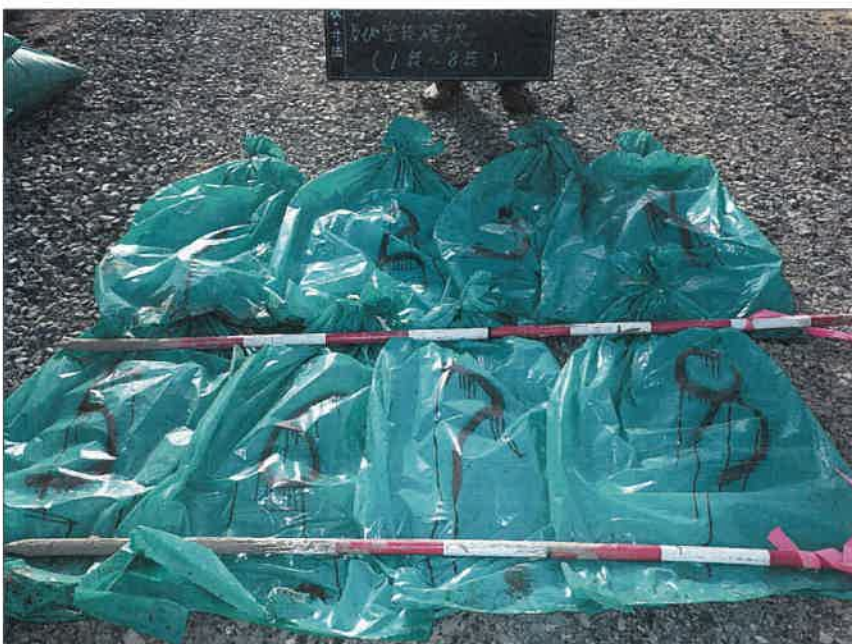
写真区分: 施工状況写真 工種: 2工区 田番 104-3 種別: 吸水渠状況 写真タイトル: モミガラ積込み後空袋確認
