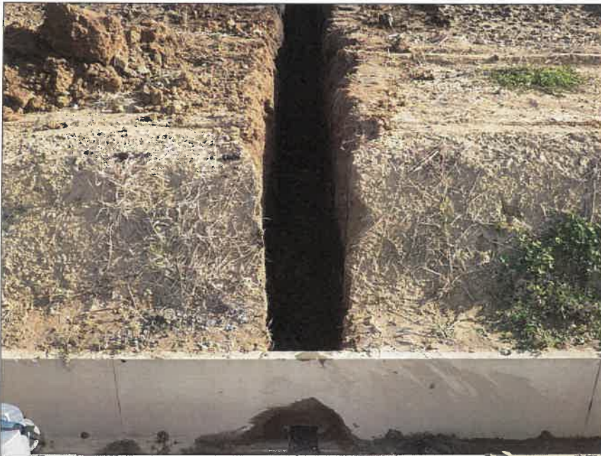
写真区分:施工状況写真 工種:2工区 田番 104-3 種別:水閘工状況 写真タイトル:床均し掘削完了
