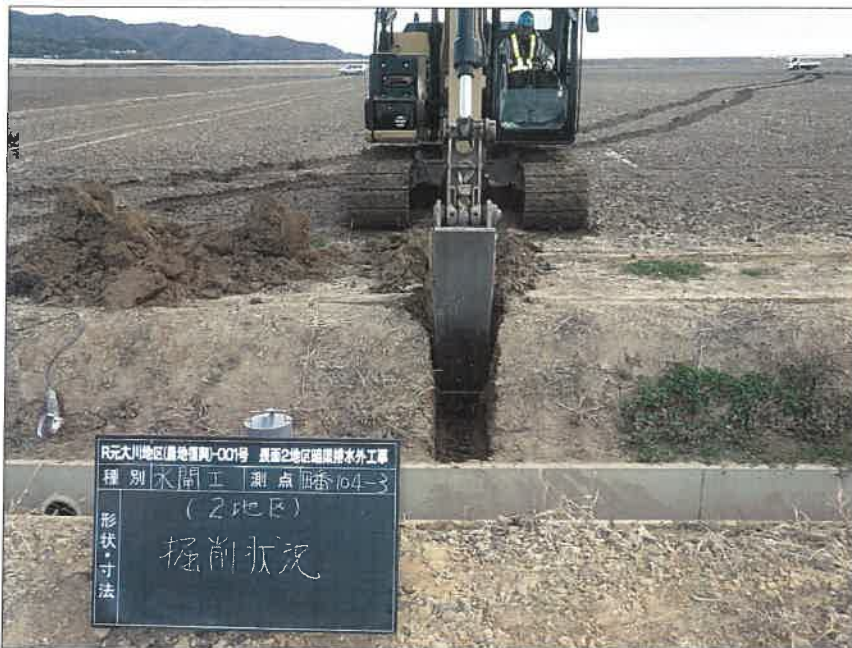
写真区分:施工状況写真 工種:2工区 田番 104-3 種別:水閘工状況 写真タイトル:掘削状況
