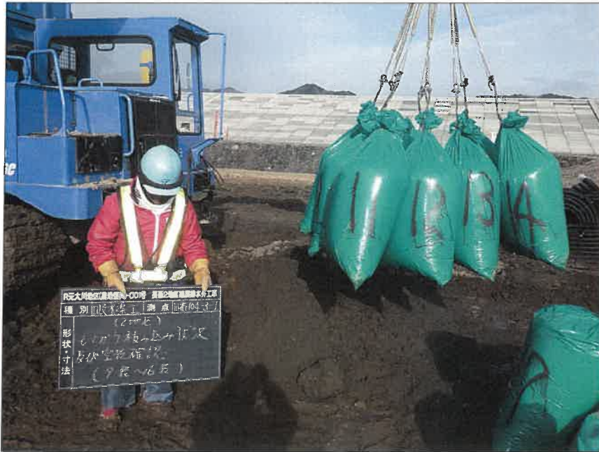
写真区分: 施工状況写真 工種: 2工区 田番 104-3 種別: 吸水渠状況 写真タイトル: モミガラ積み込み状況
