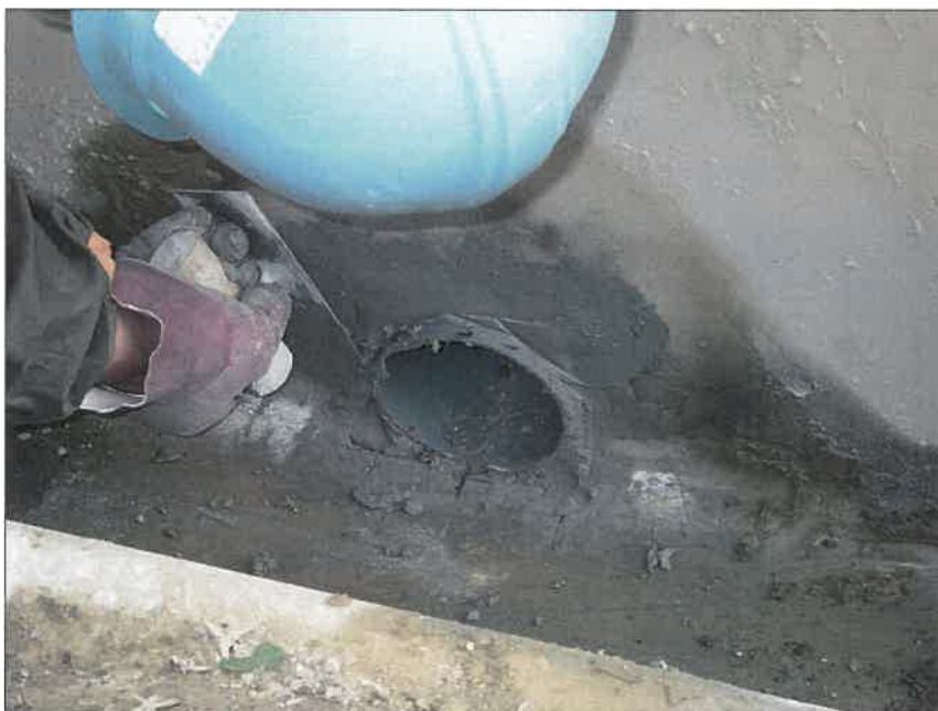
写真区分:施工状況写真 工種:2工区 田番 104-3 種別:水閘工状況 写真タイトル:吐口部モルタル 仕上げ状況
