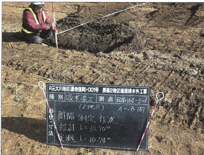
写真区分: 施工状況写真 工種: 2工区 田番 104-3 種別: 吸水渠状況 写真タイトル: 間隔測定状況
