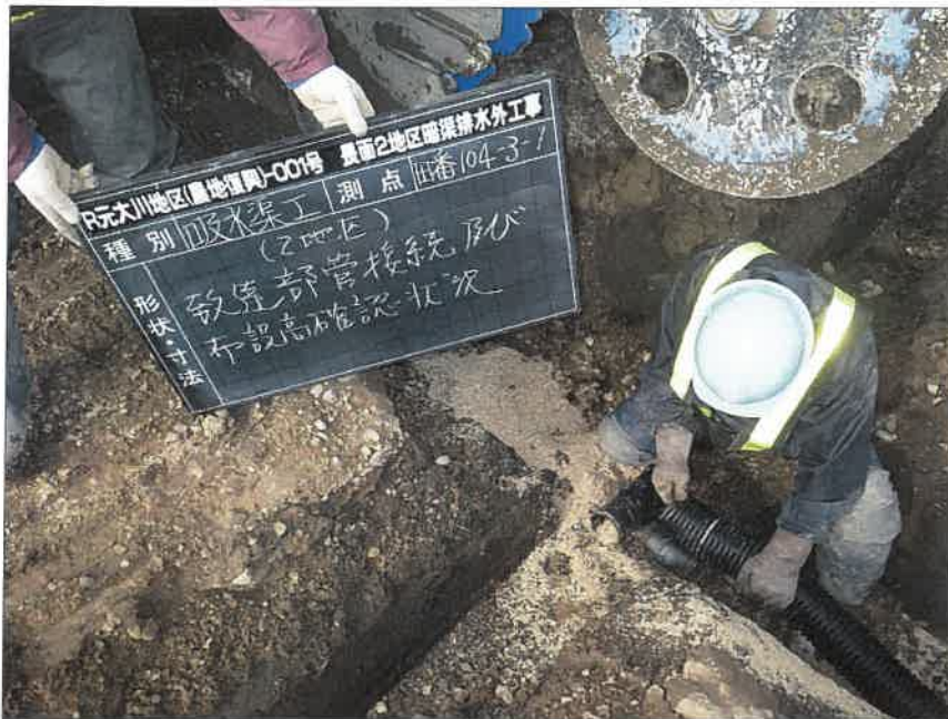
写真区分: 施工状況写真 工種: 2工区 田番 104-3 種別: 吸水渠状況 写真タイトル: 到達部管接続 状況
