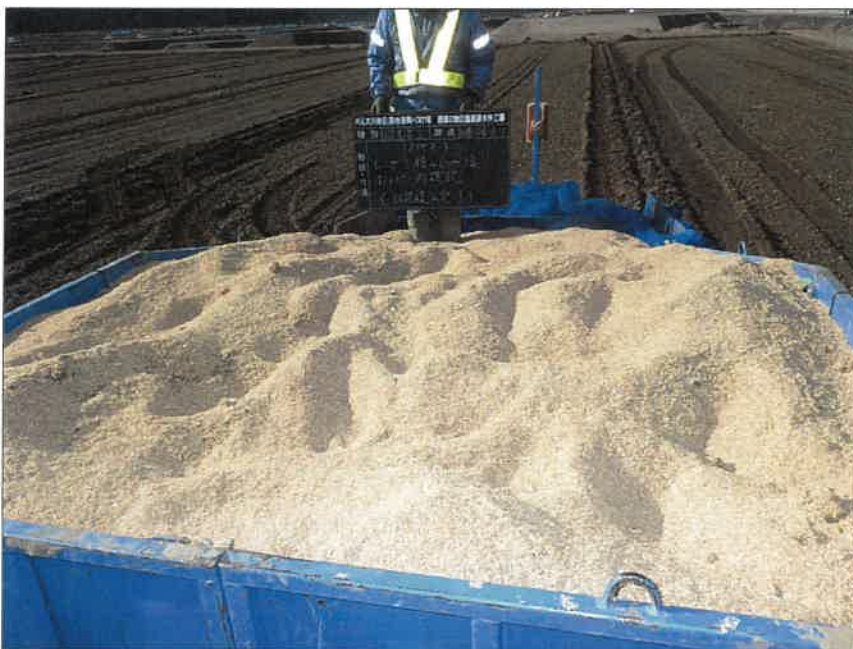
写真区分:施工状況写真 工種:2工区 田番 104-3 種別:吸水渠状況 写真タイトル:モミガラ投入 後ホッパー内確認
