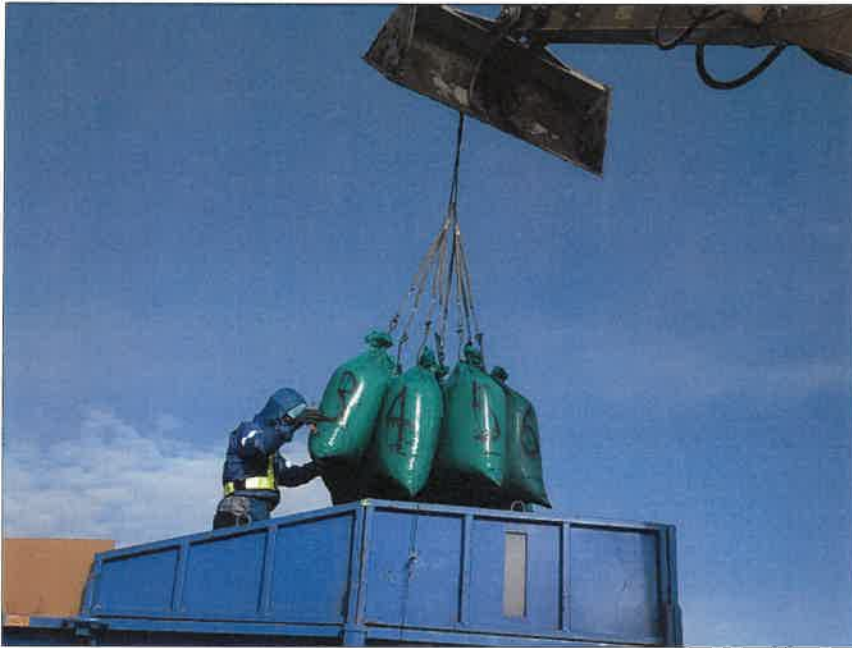
写真区分:施工状況写真 工種:2工区 田番 104-3 種別:吸水渠状況 写真タイトル:モミガラ積み み状況
