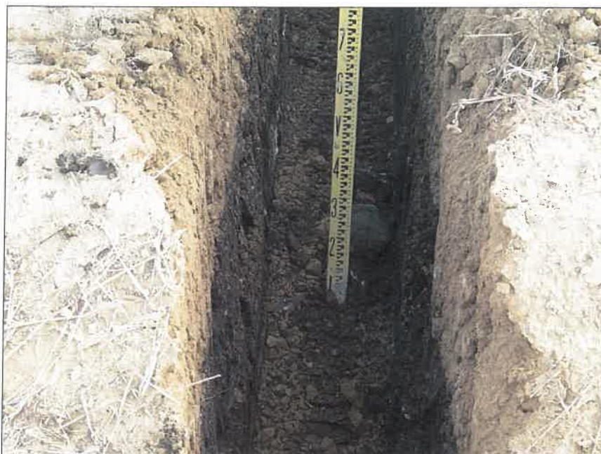
写真区分: 施工状況写真 工種: 2工区 田番 104-3 種別: 水閘工状況 写真タイトル: 掘削高測定確認状況
