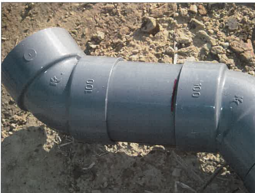
写真区分: 施工状況写真 工種: 2工区 田番 104-3 種別: 水閘工状況 写真タイトル: 水閘部組立差し込み状況
