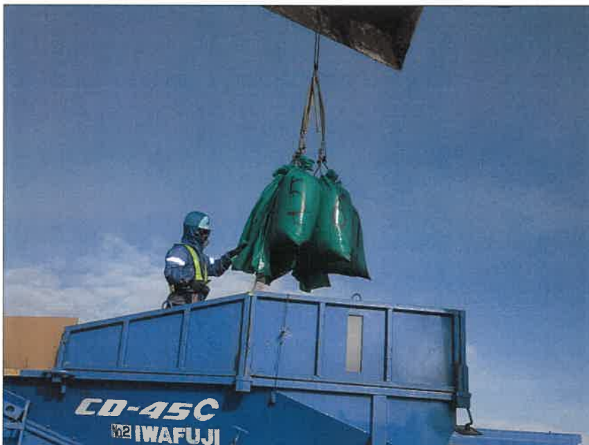
写真区分:施工状況写真 工種:2工区 田番 104-3 種別:吸水渠状況 写真タイトル:モミガラ積み み状況
