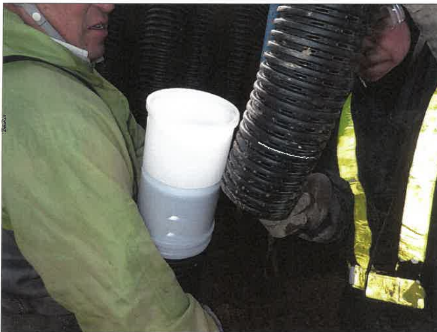
写真区分:施工状況写真 工種:2工区 田番 104-3 種別:吸水渠状況 写真タイトル:ロール管接続 差し込み状況
