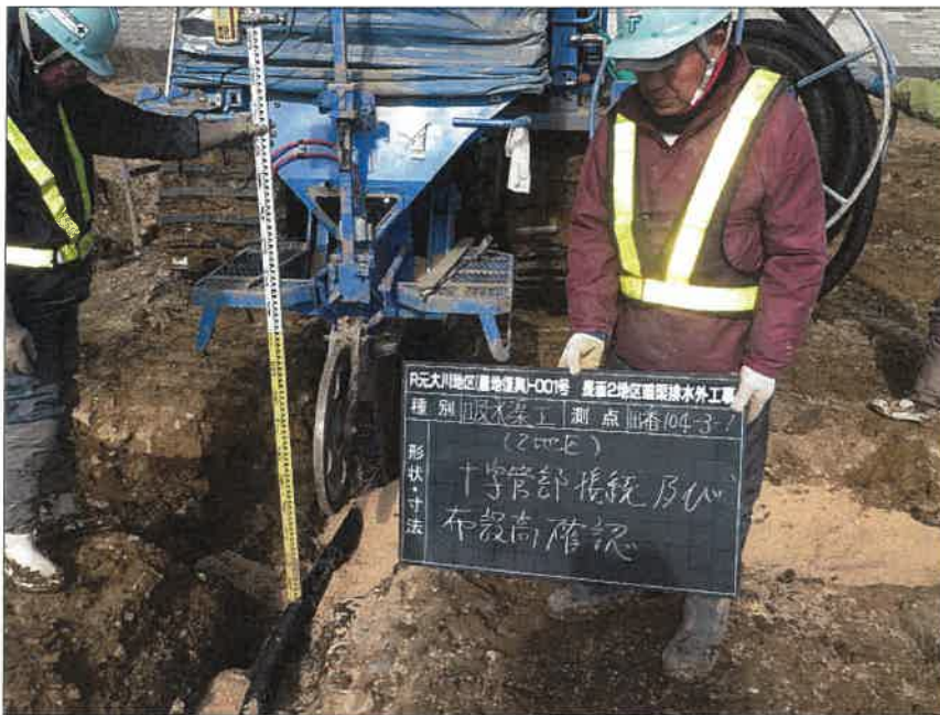
写真区分:施工状況写真 工種:2工区 田番 104-3 種別:吸水渠状況 写真タイトル:十字管部布設 高確認状況
