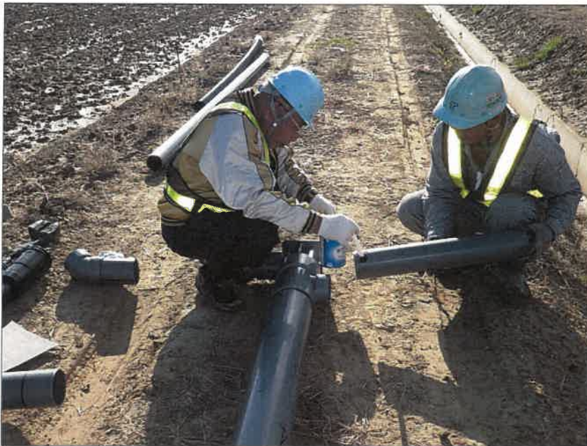
写真区分:施工状況写真 工種:2工区 田番 104-3 種別:水閘工状況 写真タイトル:水閘部組立接着状況
