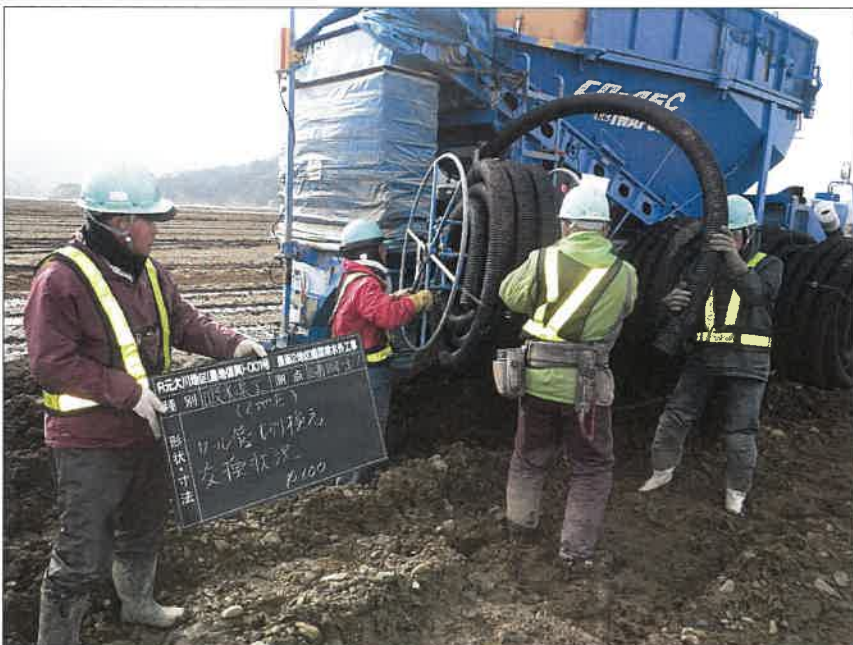
写真区分:施工状況写真 工種:2工区 田番 104-3 種別:吸水渠状況 写真タイトル:ロール管切り 替え接続状況
