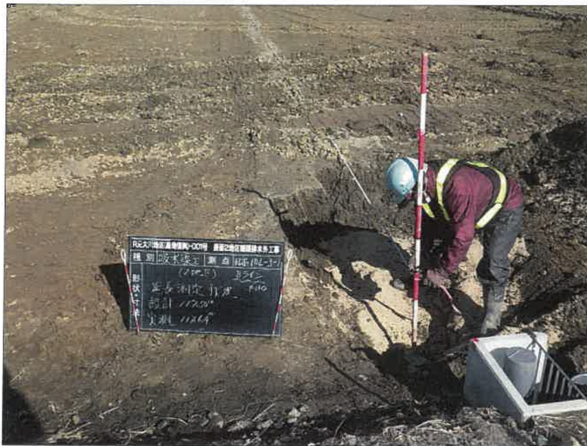
写真区分: 施工状況写真 工種: 2工区 田番 104-3 種別: 吸水渠状況 写真タイトル: 延長測定状況
