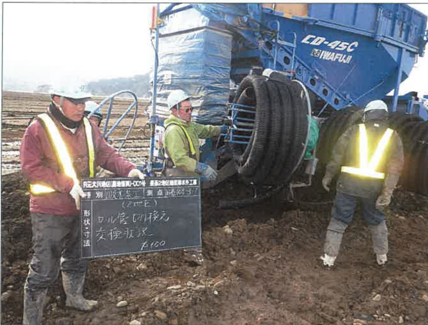
写真区分:施工状況写真 工種:2工区 田番 104-3 種別:吸水渠状況 写真タイトル:ロール管切り 替え接続状況
