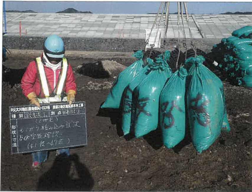
写真区分:施工状況写真 工種:2工区 田番 104-3 種別:吸水袋状況 写真タイトル:モミガラ積込 み状況
