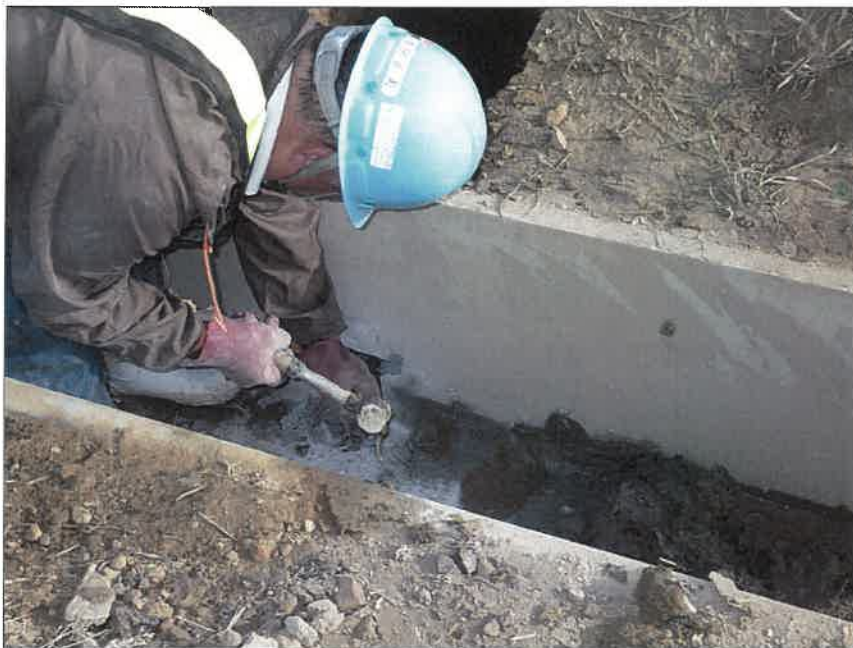
写真区分: 施工状況写真 工種: 2工区 田番 104-3 種別: 水閘工状況 写真タイトル: 吐け口開孔状況
