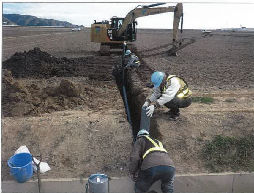
写真区分:施工状況写真 工種:2工区 田番 104-3 種別:水閘工状況 写真タイトル:水閘部設置状況
