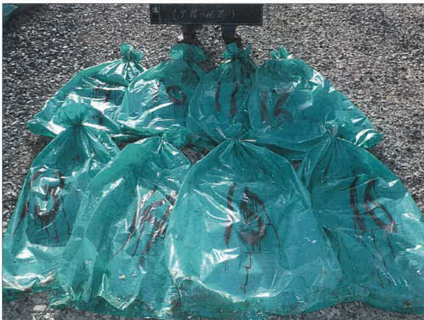
写真区分: 施工状況写真 工種: 2工区 田番 104-3 種別: 吸水渠状況 写真タイトル: モミガラ積込み後空袋確認
