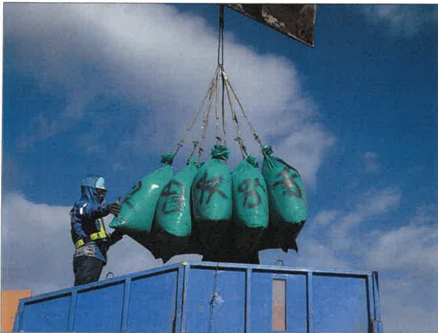
写真区分:施工状況写真 工種:2工区 田番 104-3 種別:吸水袋状況 写真タイトル:モミガラ積込 み状況
