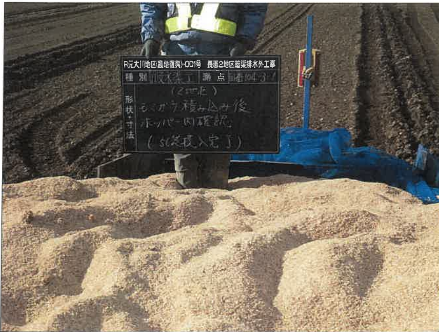
写真区分:施工状況写真 工種:2工区 田番 104-3 種別:吸水渠状況 写真タイトル:モミガラ投入 後ホッパー内確認
