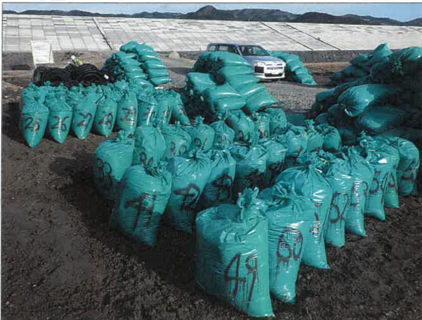
写真区分: 施工状況写真 工種: 2工区 田番 104-3 種別: 吸水渠状況 写真タイトル: モミガラ積込み数量確認
