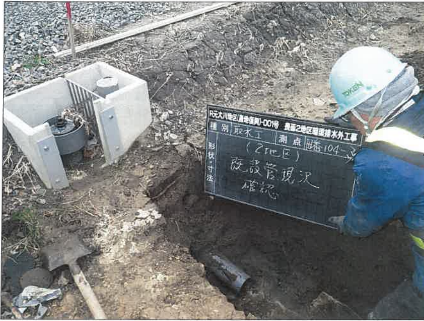
写真区分: 施工状況写真 工種: 2工区 田番 104-3 種別: 取水工状況 写真タイトル: 既設管現況確認
