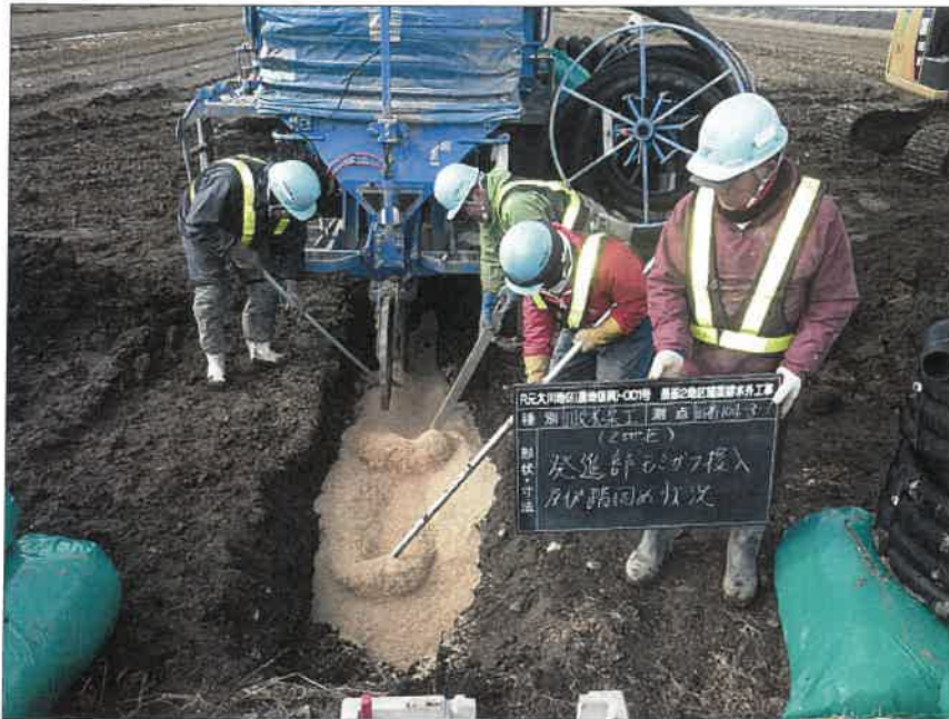
写真区分:施工状況写真 工種:2工区 田番 104-3 種別:吸水渠状況 写真タイトル:発進部モミガラ投入状況
