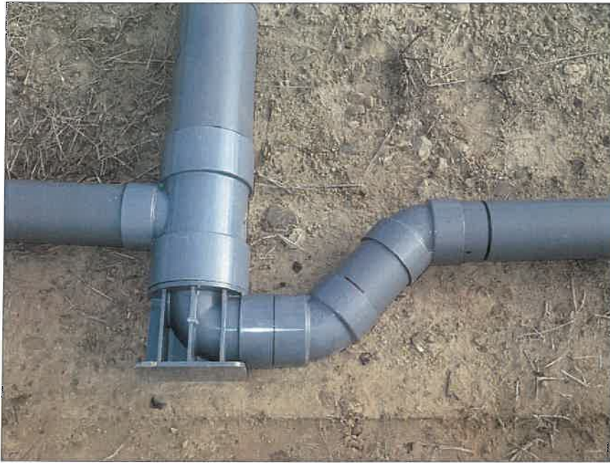
写真区分:施工状況写真 工種:2工区 田番 104-3 種別:水閘工状況 写真タイトル:水閘部組立完了
