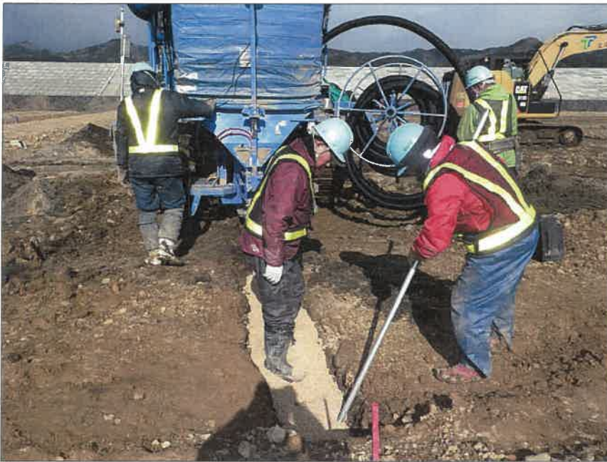
写真区分: 施工状況写真 工種: 2工区 田番 104-3 種別: 吸水渠状況 写真タイトル: 接続部モミガラ投入踏み固め状況
