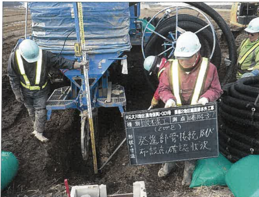
写真区分:施工状況写真 工種:2工区 田番 104-3 種別:吸水渠状況 写真タイトル:発進部管布設 高確認状況
