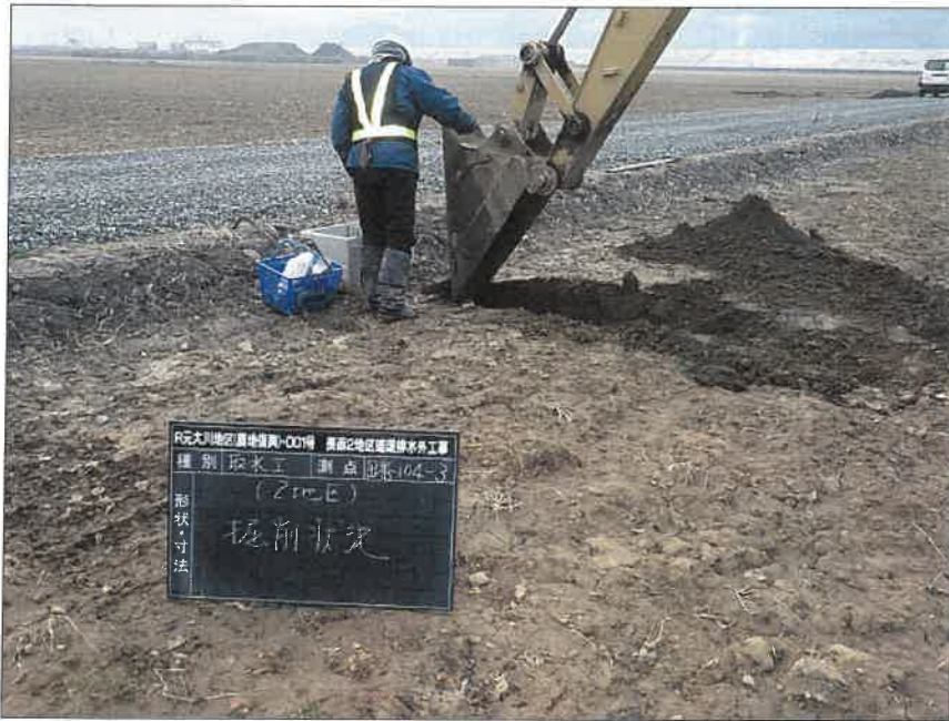
写真区分: 施工状況写真 工種: 2工区 田番 104-3 種別: 取水工状況 写真タイトル: 掘削状況
