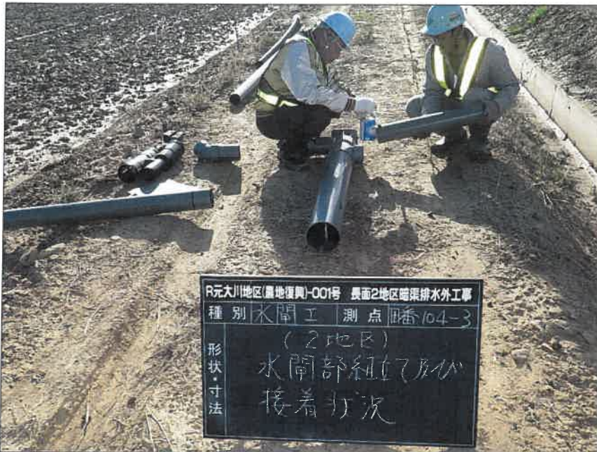
写真区分:施工状況写真 工種:2工区 田番 104-3 種別:水閘工状況 写真タイトル:水閘部組立接着状況
