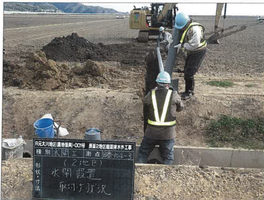
写真区分:施工状況写真 工種:2工区 田番 104-3 種別:水閘工状況 写真タイトル:水閘部設置状況
