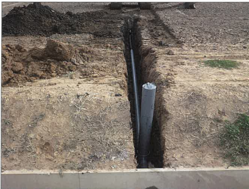
写真区分:施工状況写真 工種:2工区 田番 104-3 種別:水閘工状況 写真タイトル:水閘部設置完了
