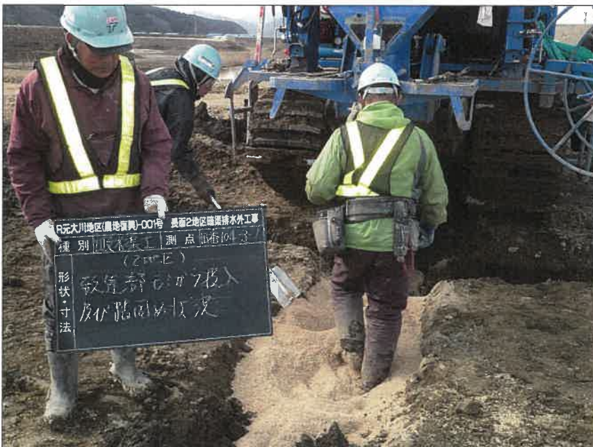
写真区分: 施工状況写真 工種: 2工区 田番 104-3 種別: 吸水渠状況 写真タイトル: 到達部モミガラ投入状況
