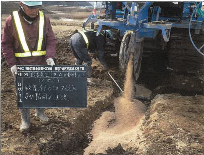
写真区分: 施工状況写真 工種: 2工区 田番 104-3 種別: 吸水渠状況 写真タイトル: 到達部モミガラ投入状況
