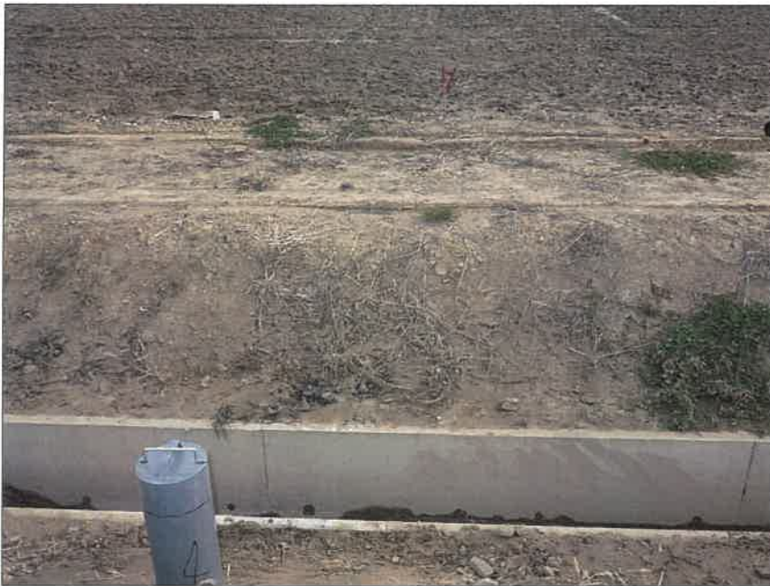
写真区分:施工状況写真 工種:2工区 田番 104-3 種別:水閘工状況 写真タイトル:着工前
