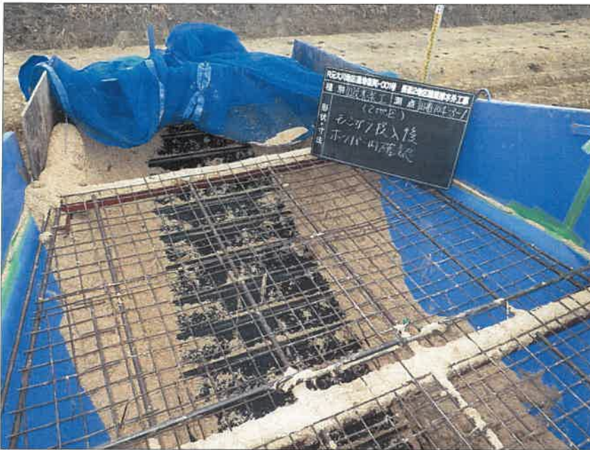
写真区分:施工状況写真 工種:2工区 田番 104-3 種別:吸水渠状況 写真タイトル:モミガラ投入 後ホッパー内残量確認
