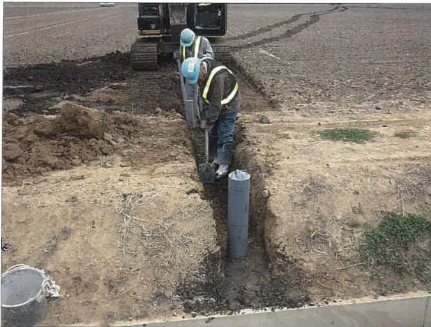
写真区分:施工状況写真 工種:2工区 田番 104-3 種別:水閘工状況 写真タイトル:埋戻し及び人 カヲ転圧状況
