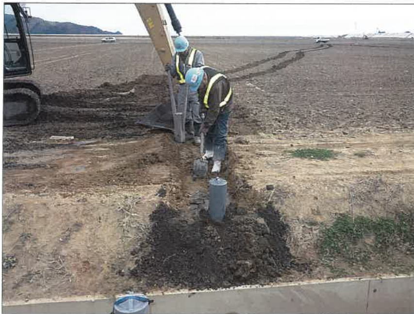
写真区分: 施工状況写真 工種: 2工区 田番 104-3 種別: 水閘工状況 写真タイトル: 埋戻し及び人カヲコ転圧状況
