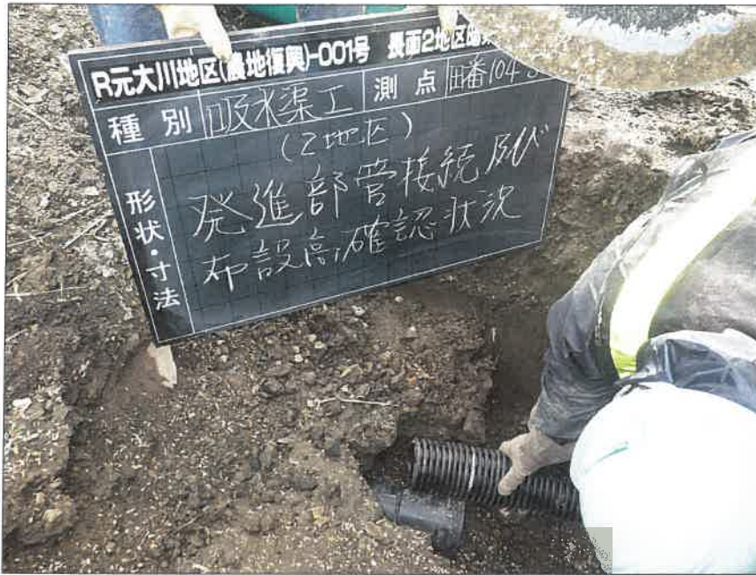
写真区分:施工状況写真 工種:2工区 田番 104-3 種別:吸水渠状況 写真タイトル:発進部管接続 状況
