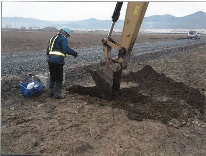
写真区分: 施工状況写真 工種: 2工区 田番 104-3 種別: 取水工状況 写真タイトル: 掘削状況
