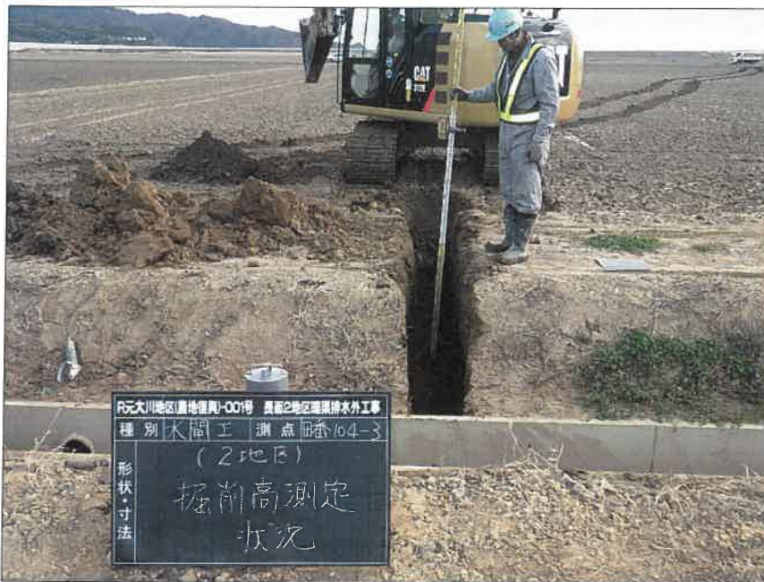
写真区分:施工状況写真 工種:2工区 田番 104-3 種別:水閘工状況 写真タイトル:掘削高測定確認状況
