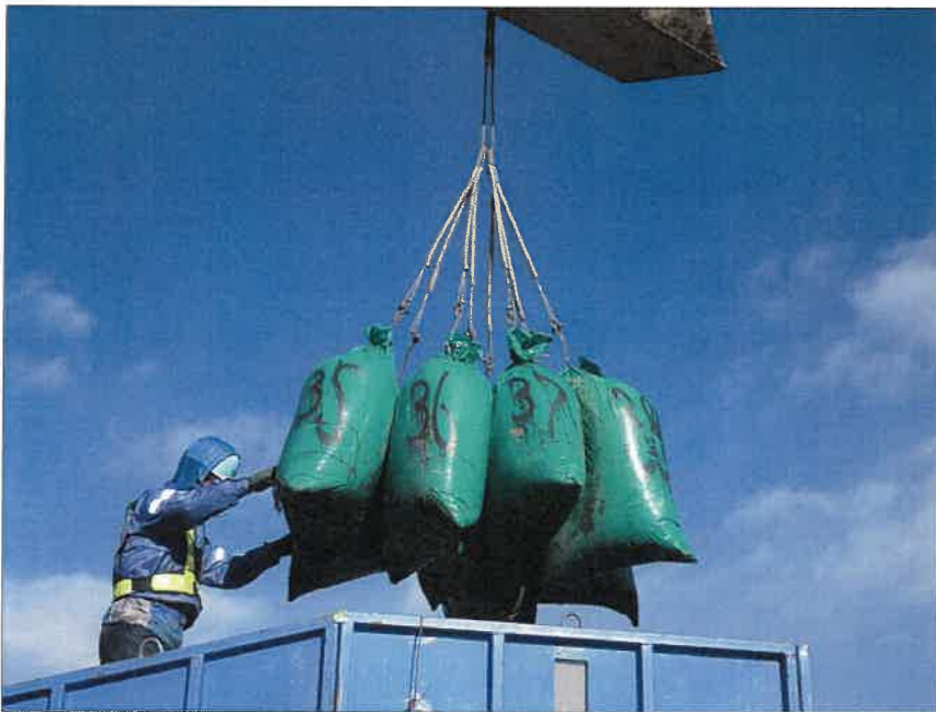
写真区分:施工状況写真 工種:2工区 田番 104-3 種別:吸水渠状況 写真タイトル:モミガラ積込み状況
