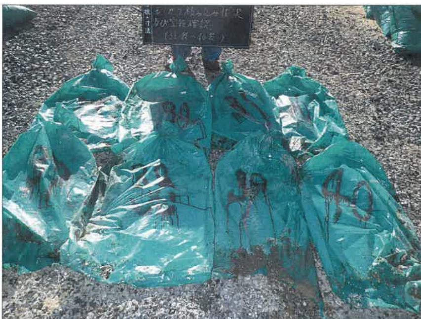
写真区分:施工状況写真 工種:2工区 田番 104-3 種別:吸水渠状況 写真タイトル:ゴミガラ積み 込み後空袋確認
