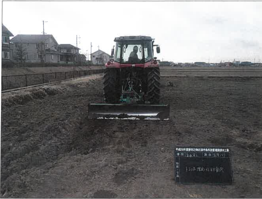
暗渠排水工 富里工区177 集水渠工 トラクター埋戻し仕上げ状況
