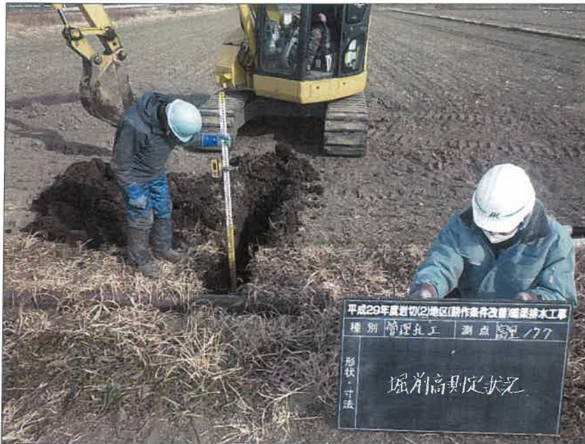
写真区分: 施工状況写真 工種: 暗渠排水工 種別: 富里工区177 細別: 管理孔工 写真タイトル: 掘削高測定状況
