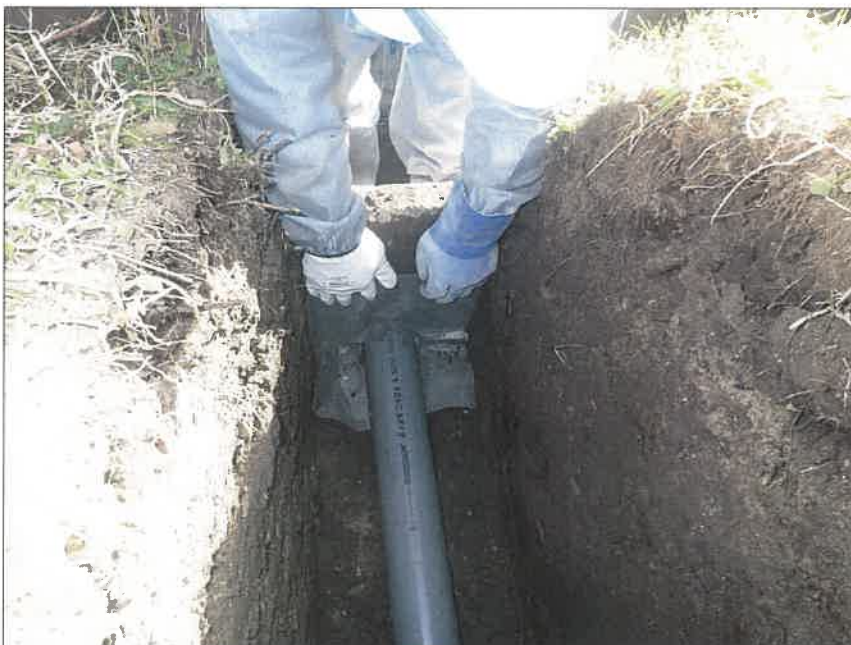
暗渠排水工 富里工区177 水閘工 吸出し防止マット取付状況
