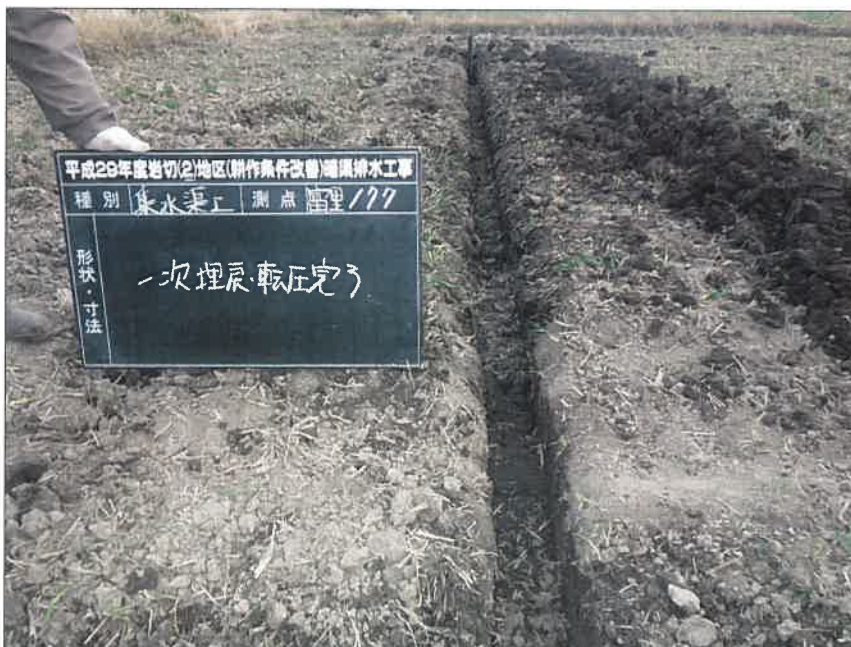
暗渠排水工 富里工区177 集水渠工 人力一次埋戻し・転圧状況(B ~C)
