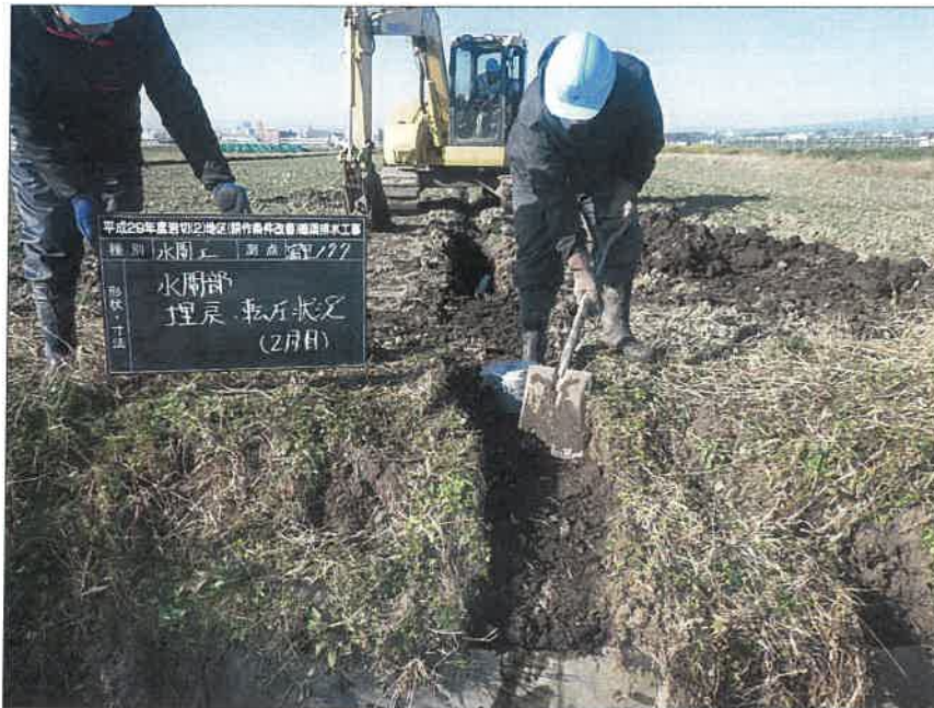
暗渠排水工 富里工区177 水閘工 水閘部 埋戻・転圧状況(2層目)
