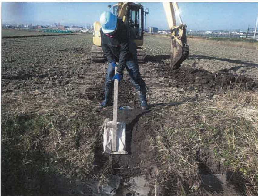
暗渠排水工 富里工区177 水閘工 法面仕上げ状況
