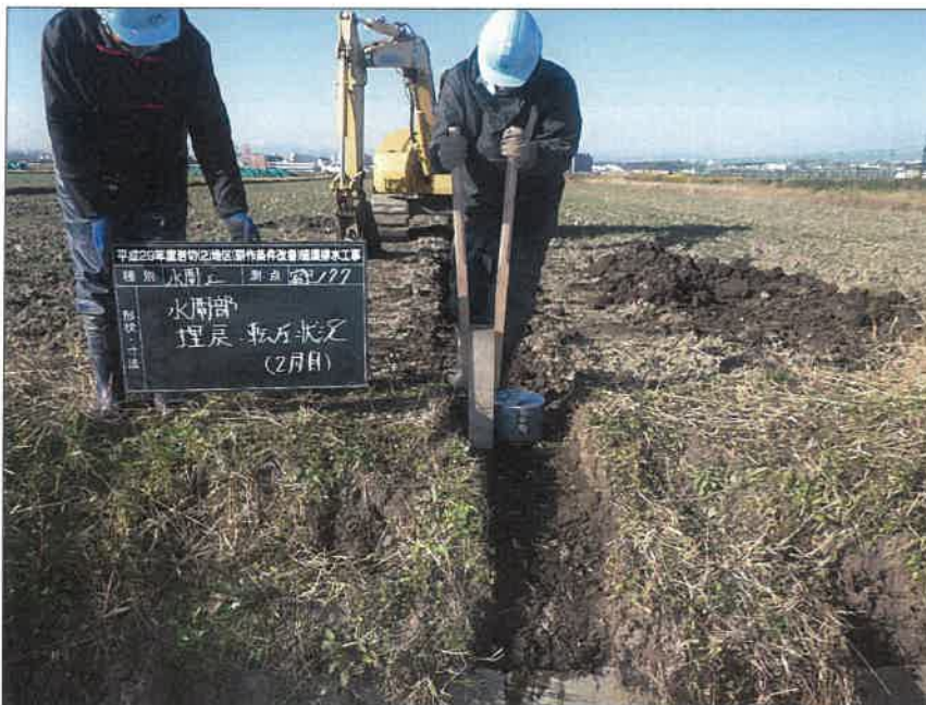
暗渠排水工 富里工区177 水閘工 水閘部 埋戻・転圧状況(2層目)
