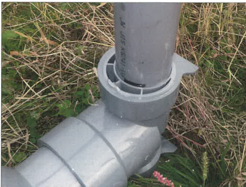
暗渠排水工 富里工区177 水閘工 差込完了
