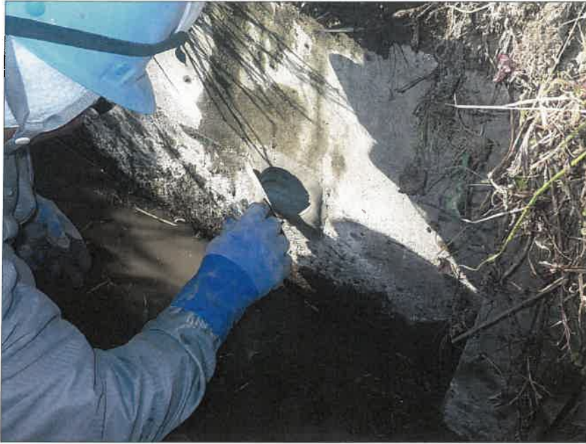
暗渠排水工 富里工区177 水閘工 吐口モルタル仕上げ状況
