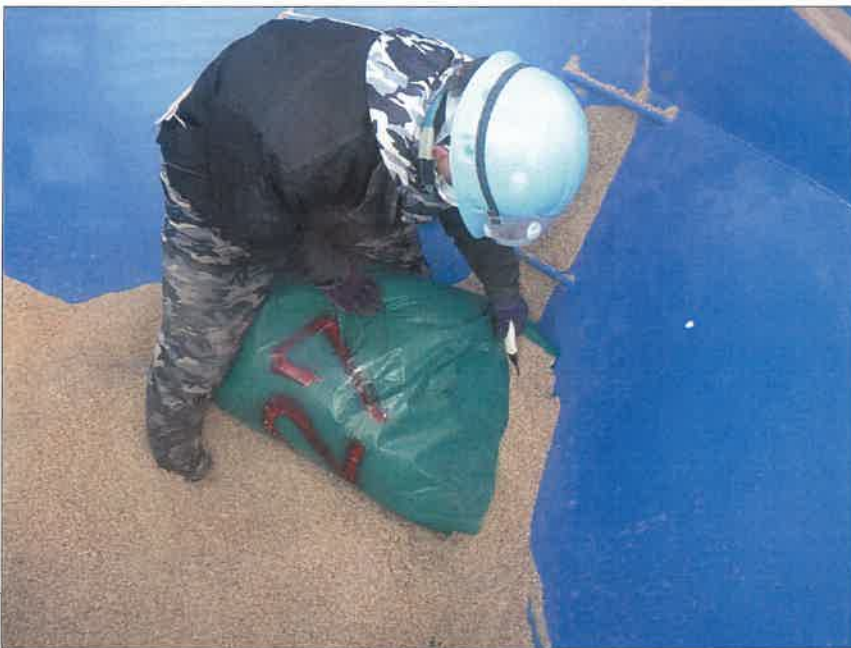
暗渠排水工 富里工区177 吸水渠工 モミガラ追加投入状況
