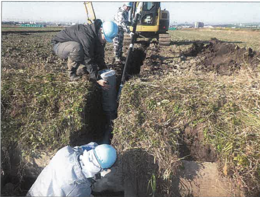
暗渠排水工 富里工区177 水閘工 管(水閘)布設状況
