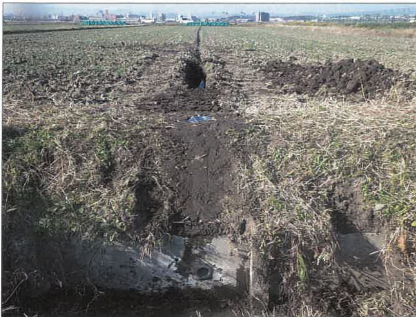
暗渠排水工 富里工区177 水閘工 水閘部 完了
