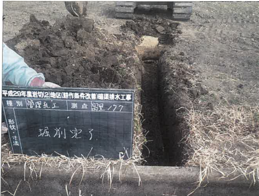
写真区分: 施工状況写真 工種: 暗渠排水工 種別: 富里工区177 細別: 管理孔工 写真タイトル: 掘削完了
