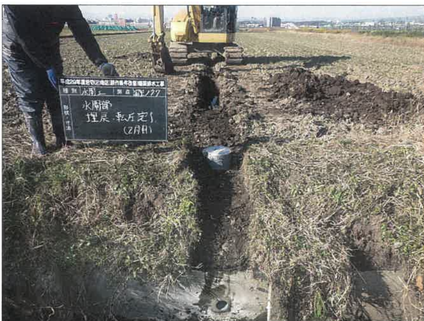
暗渠排水工 富里工区177 水閘工 水閘部 埋戻・転圧完了(2層目)
