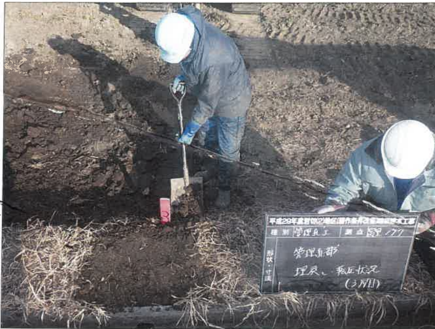
写真区分: 施工状況写真 工種: 暗渠排水工 種別: 富里工区177 細別: 管理孔工 写真タイトル: 管理孔部 埋 戻し・転圧状況(3層目)
