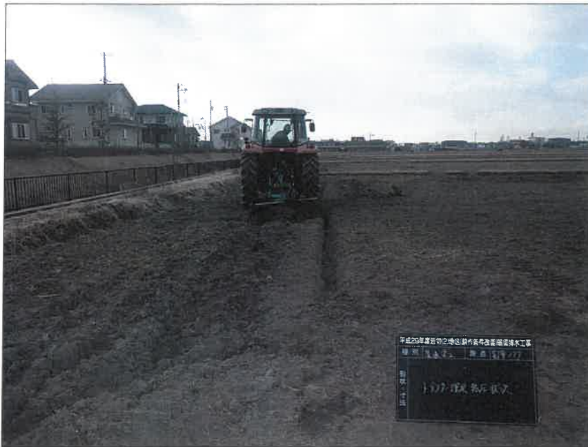
暗渠排水工 富里工区177 集水渠工 トラクター埋戻し状況
