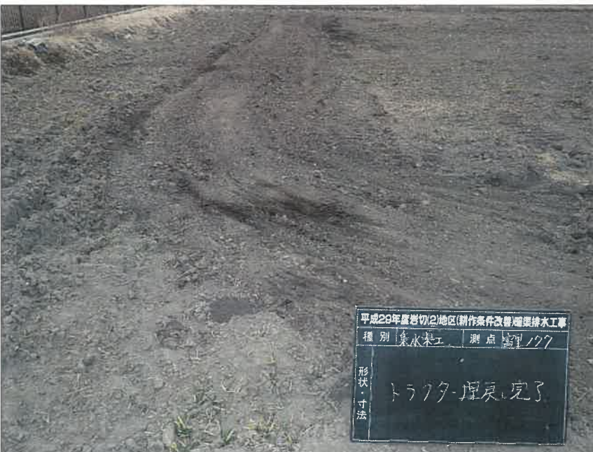
暗渠排水工 富里工区177 集水渠工 トラクター埋戻し完了
