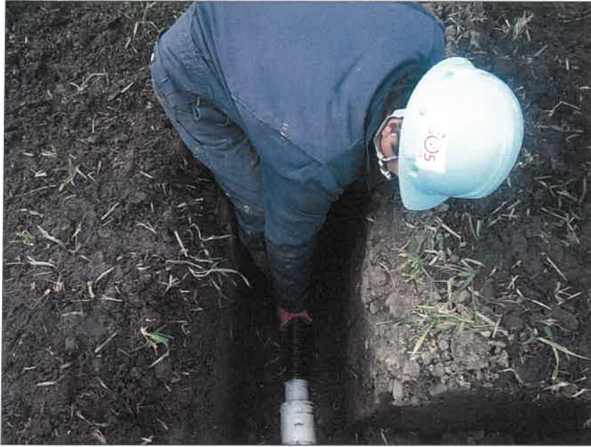
暗渠排水工 富里工区177 吸水渠工 吸水管接続状況(接続部)
