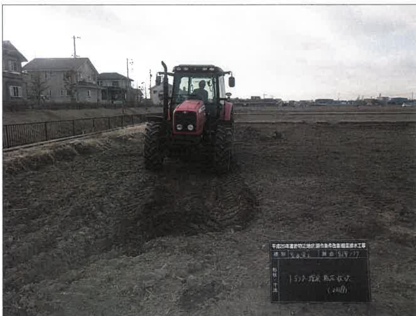
暗渠排水工 富里工区177 集水渠工 トラクター転圧状況(2回目)
