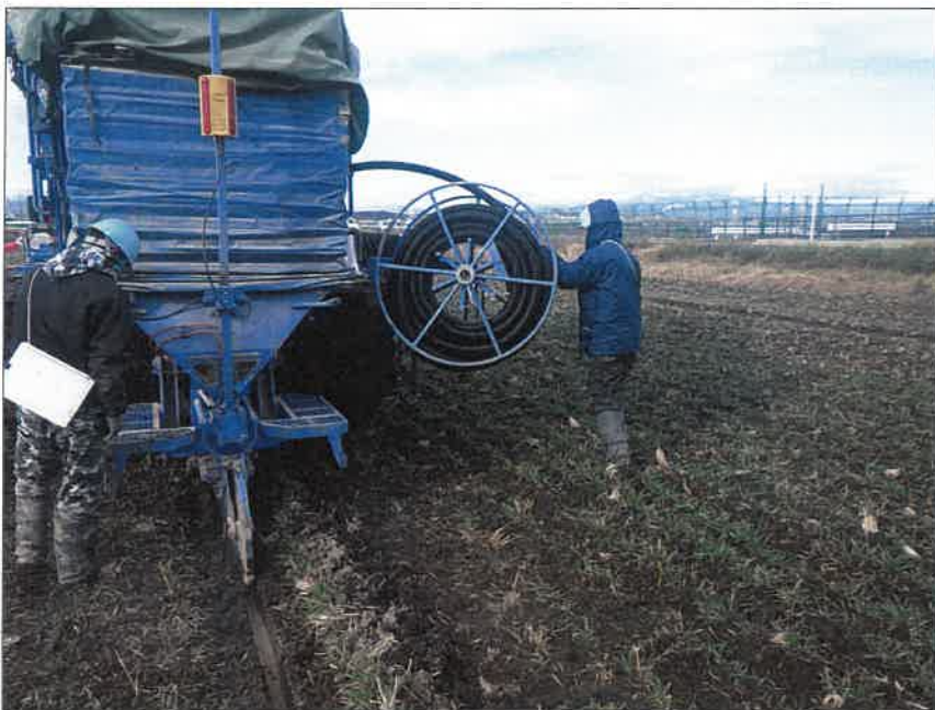
暗渠排水工 富里工区177 吸水渠工 吸水管布設状況
