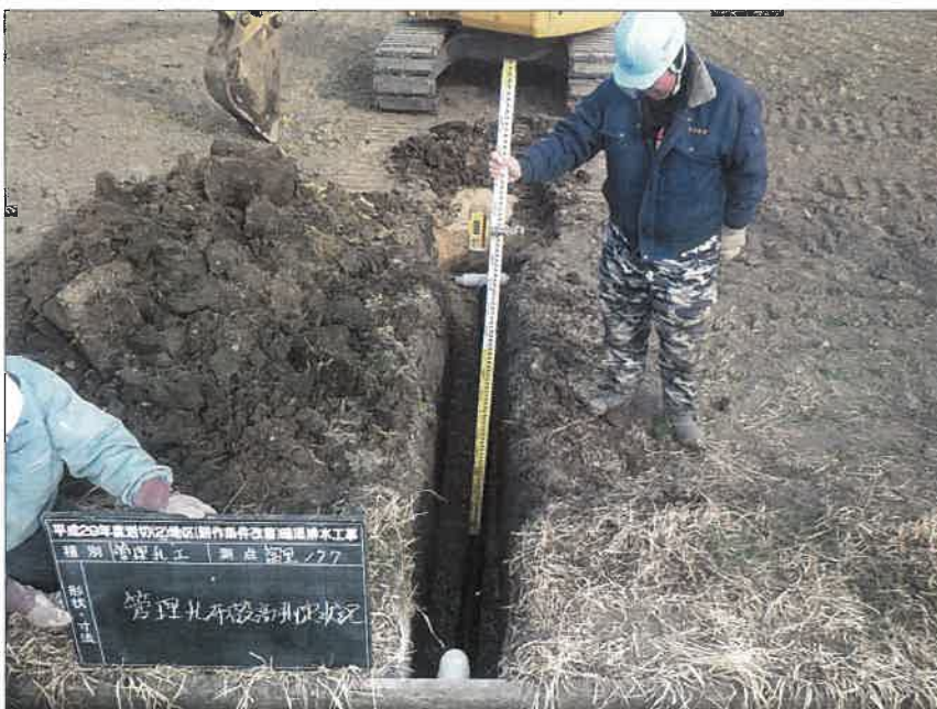
写真区分: 施工状況写真 工種: 暗渠排水工 種別: 富里工区177 細別: 管理孔工 写真タイトル: 管理孔布設高測定状況
