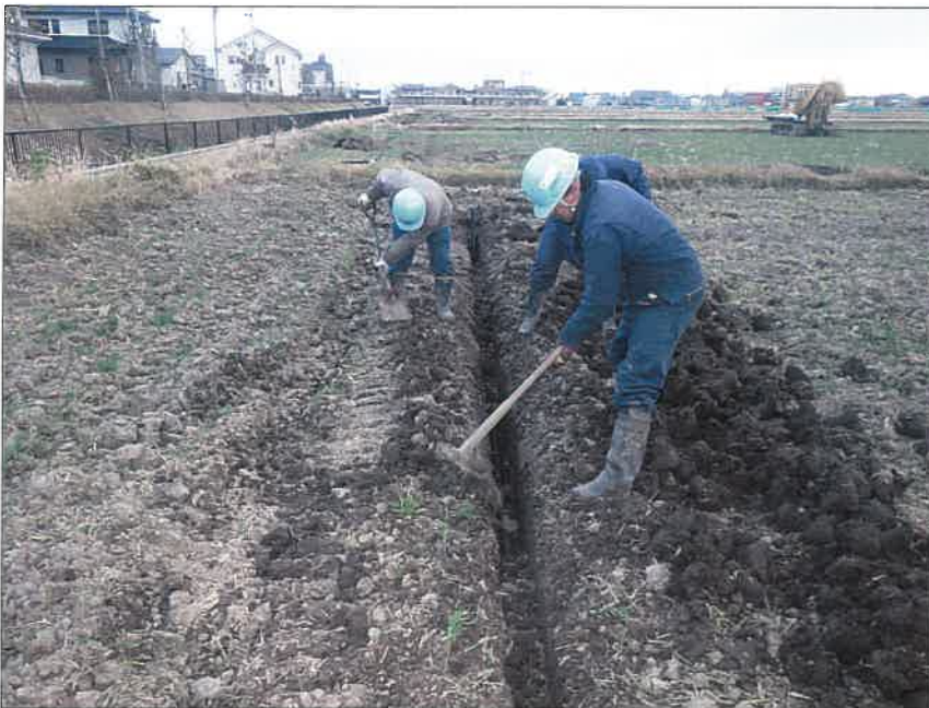
暗渠排水工 富里工区177 集水渠工 人力一次埋戻し・転圧状況
