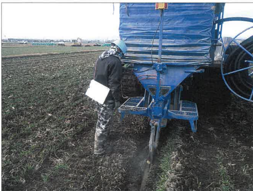
暗渠排水工 富里工区177 吸水渠工 吸水管布設状況
