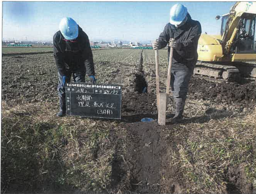
暗渠排水工 富里工区177 水閘工 水閘部 埋戻・転圧状況(3層目)
