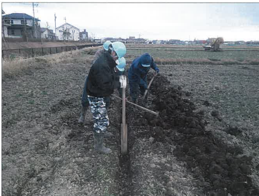
暗渠排水工 富里工区177 集水渠工 人力一次埋戻し・転圧状況
