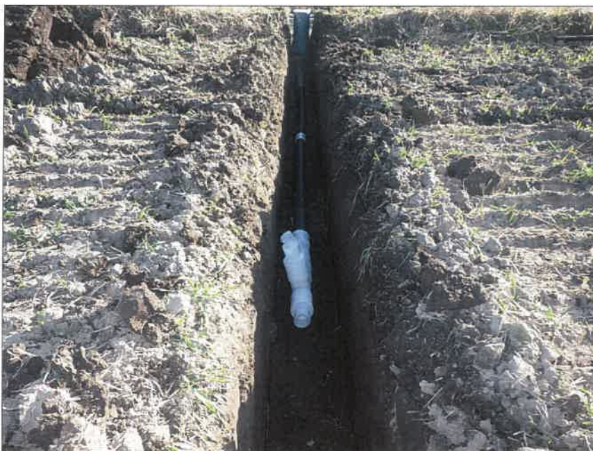
暗渠排水工 富里工区177 水閘工 管(水閘)布設完了
