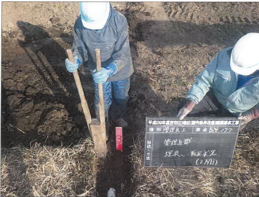
写真区分:施工状況写真 工種:暗渠排水工 種別:富里工区177 細別:管理孔工 写真タイトル:管理孔部 埋戻し・転圧状況(2層目)
