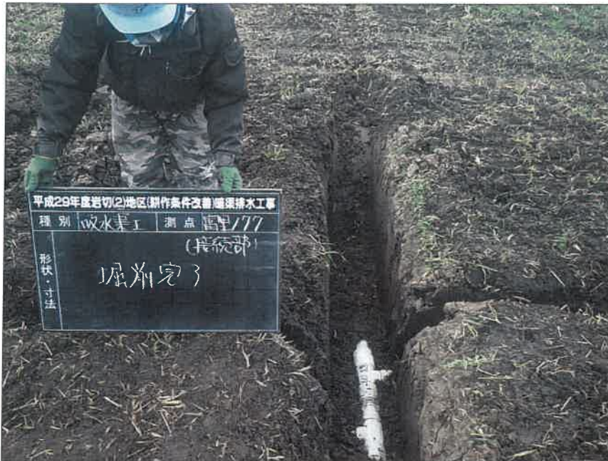
暗渠排水工 富里工区177 吸水渠工 掘削完了(接続部)
