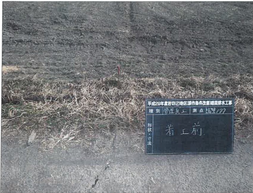
写真区分:施工状況写真 工種:暗渠排水工 種別:富里工区177 細別:管理孔工 写真タイトル:管理孔部 着工前
