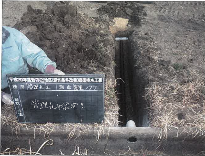
写真区分:施工状況写真 工種:暗渠排水工 種別:富里工区177 細別:管理孔工 写真タイトル:管理孔布設完了
