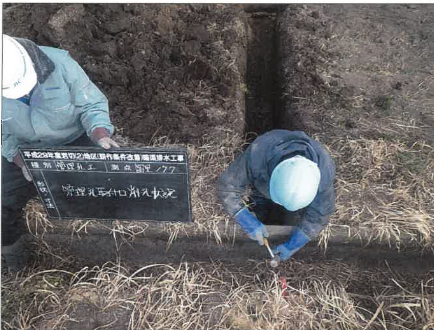
写真区分: 施工状況写真 工種: 暗渠排水工 種別: 富里工区177 細別: 管理孔工 写真タイトル: 管理孔取付口 削孔状況
