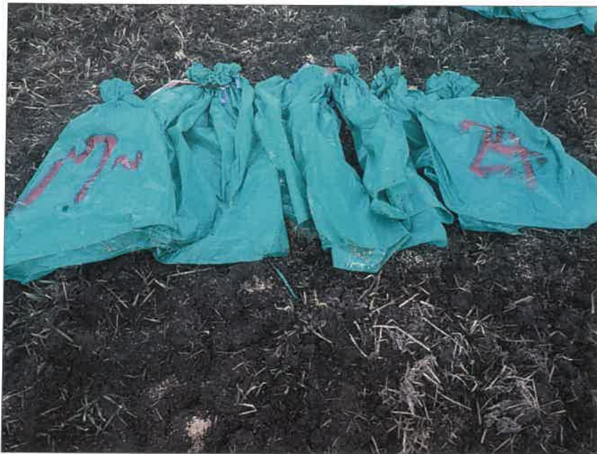
暗渠排水工 富里工区177 吸水渠工 モミガラ空袋確認(17~24袋)
