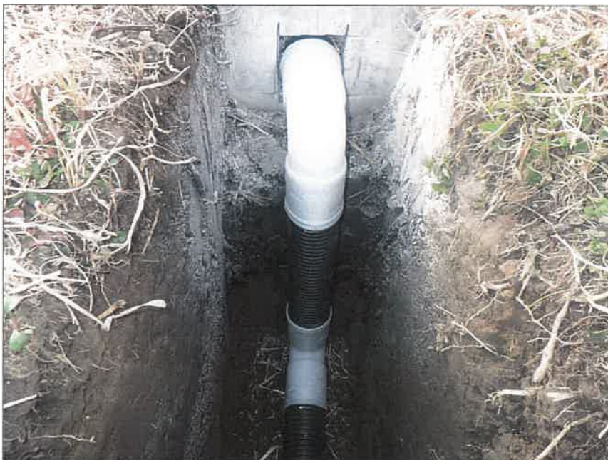
写真区分:施工状況写真 工種:暗渠排水工 種別:富里工区177 細別:管理孔工 写真タイトル:管理孔布設完了
