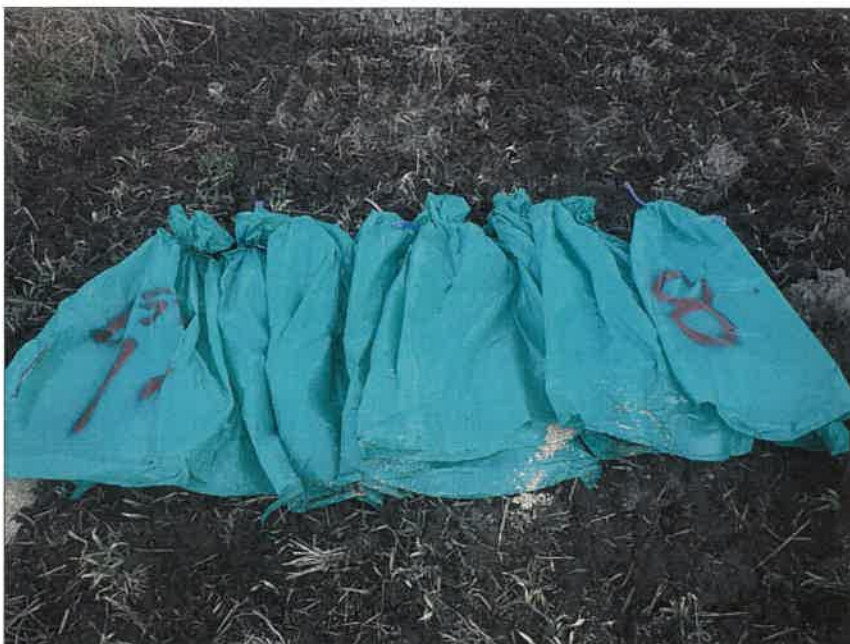
暗渠排水工 富里工区177 吸水渠工 モミガラ空袋確認(1~8袋)
