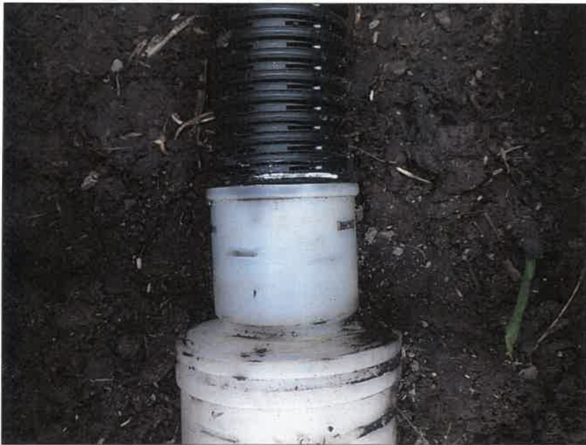
暗渠排水工 富里工区177 吸水渠工 吸水管接続完了(接続部)
