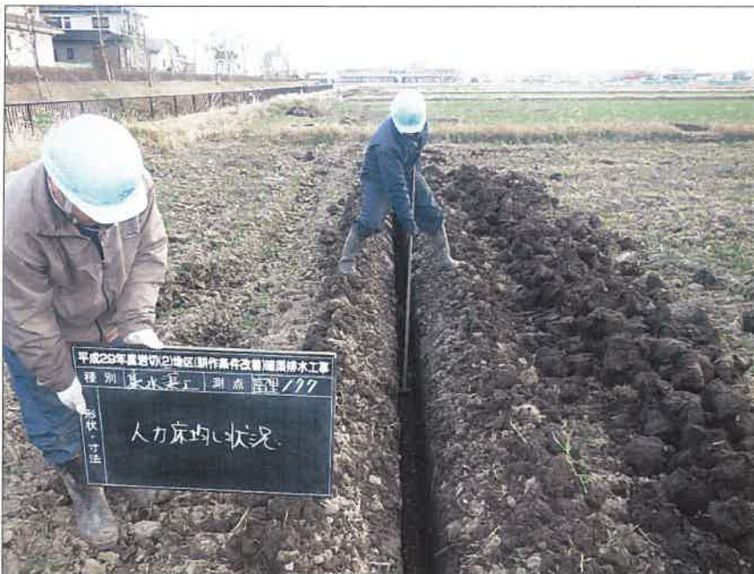
暗渠排水工 富里工区177 集水渠工 人力床均し状況
