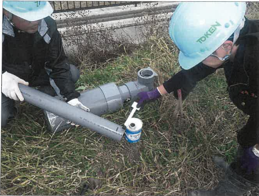
暗渠排水工 富里工区177 水閘工 接着剂塗布状況
