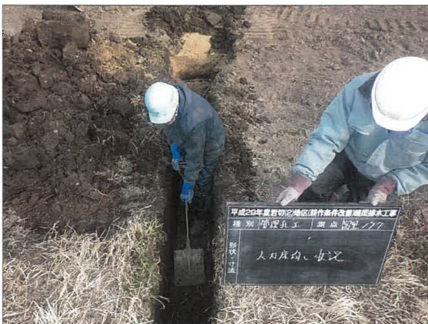
写真区分: 施工状況写真 工種: 暗渠排水工 種別: 富里工区177 細別: 管理孔工 写真タイトル: 人力床均し状況
