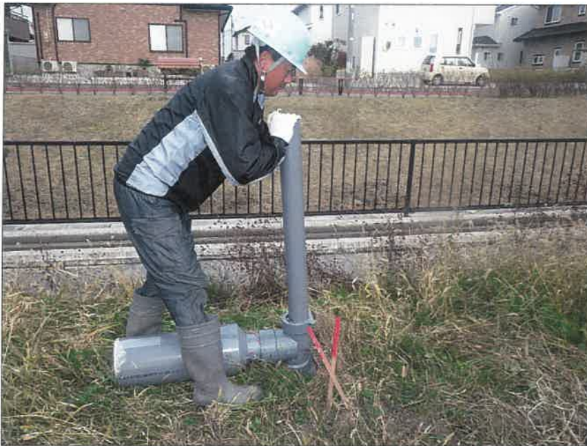
暗渠排水工 富里工区177 水閘工 差込状況
