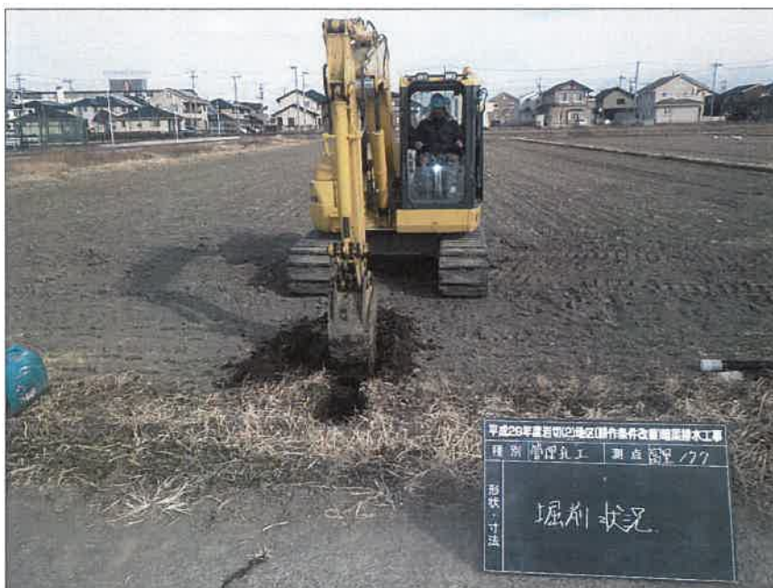
写真区分:施工状況写真 工種:暗渠排水工 種別:富里工区177 細別:管理孔工 写真タイトル:掘削状況
