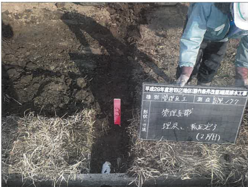
写真区分:施工状況写真 工種:暗渠排水工 種別:富里工区177 細別:管理孔工 写真タイトル:管理孔部 埋戻し・転圧完了(2層目)
