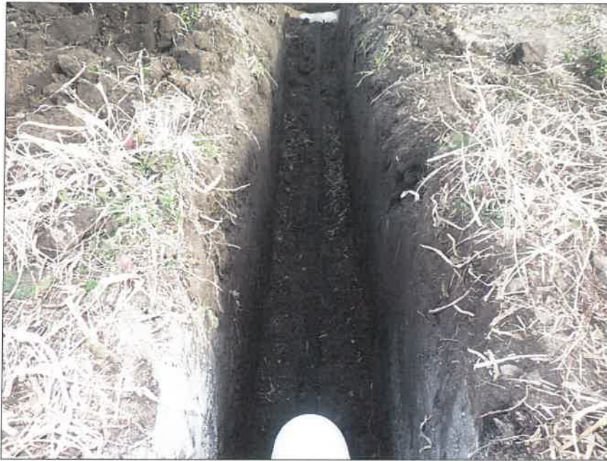
写真区分: 施工状況写真 工種: 暗渠排水工 種別: 富里工区177 細別: 管理孔工 写真タイトル: 管巻き立て埋戻し完了
