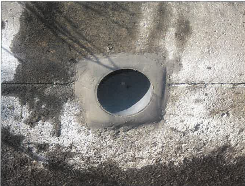
暗渠排水工 富里工区177 水閘工 吐口モルタル仕上げ完了
