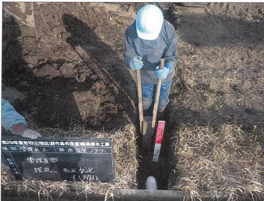
写真区分: 施工状況写真 工種: 暗渠排水工 種別: 富里工区177 細別: 管理孔工 写真タイトル: 管理孔部 埋戻し・転圧状況(1層目)
