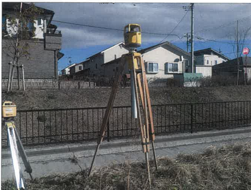
暗渠排水工 富里工区177 吸水渠工 レーザーレベル設置状況
