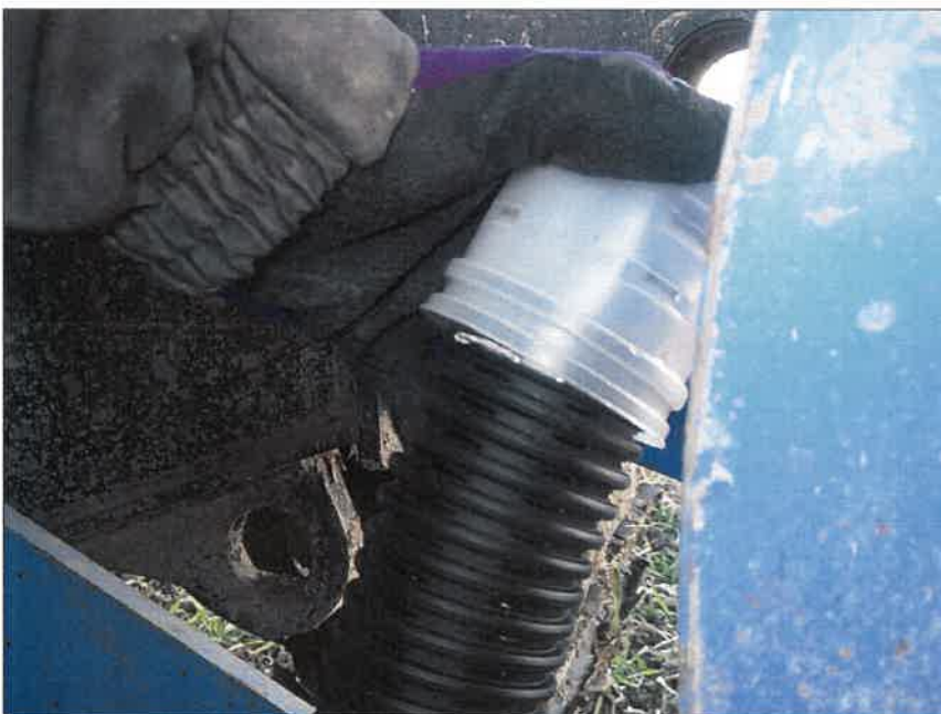
暗渠排水工 富里工区177 吸水渠工 末端処理(キャップ止)
