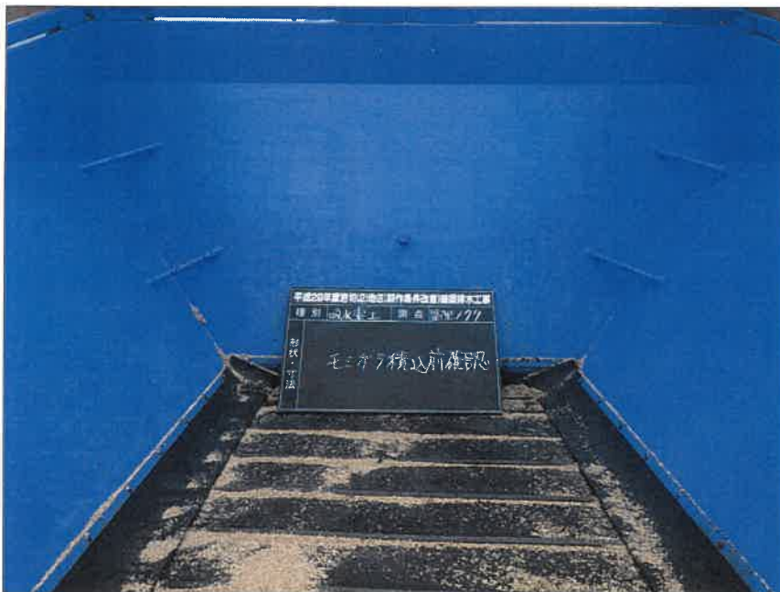
暗渠排水工 富里工区177 吸水渠工 モミガラ積込み前確認(空車)
