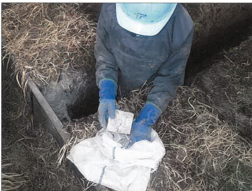
写真区分: 施工状況写真 工種: 暗渠排水工 種別: 富里工区177 細別: 管理孔工 写真タイトル: 削孔ガラ拾集 め状況
