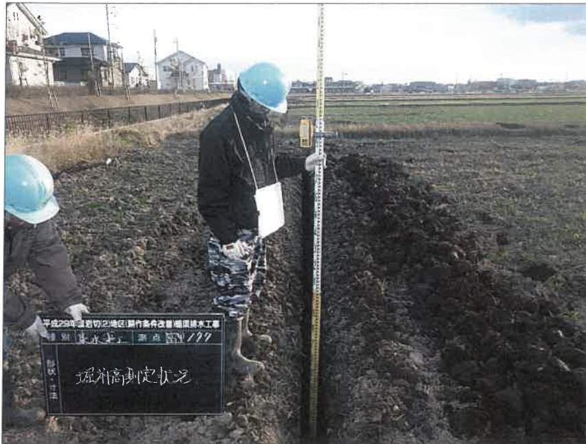
暗渠排水工 富里工区177 集水渠工 掘削高測定状況
