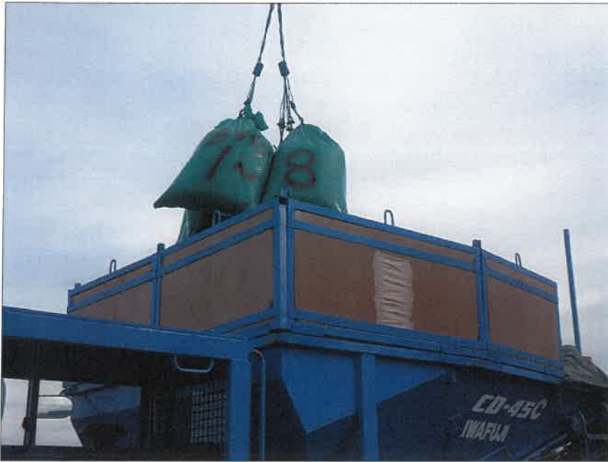
暗渠排水工 富里工区177 吸水渠工 モミガラ積込み状況(1~8袋)
