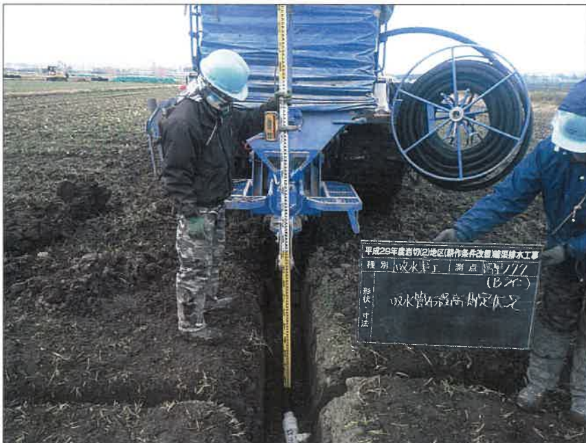
暗渠排水工 富里工区177 吸水渠工 吸水管布設高測定状況
