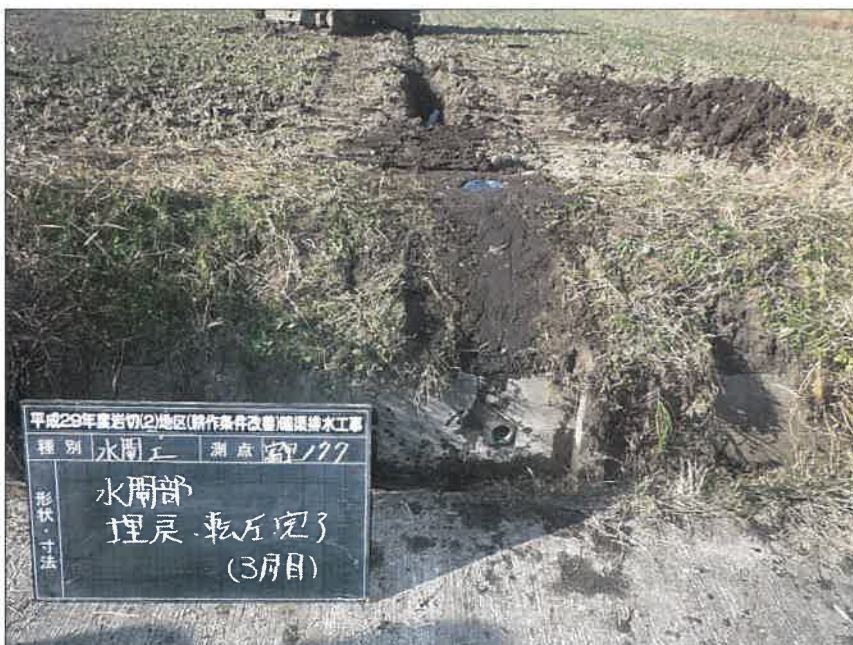
暗渠排水工 富里工区177 水閘工 水閘部 埋戻・転圧完了(3層目)
