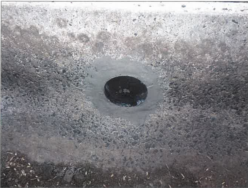
写真区分: 施工状況写真 工種: 暗渠排水工 種別: 富里工区177 細別: 管理孔工 写真タイトル: モルタル仕上げ完了
