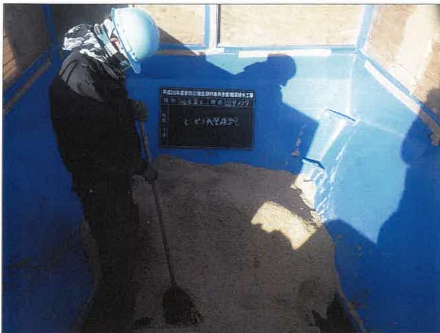
暗渠排水工 富里工区177 吸水渠工 モミガラ残量確認
