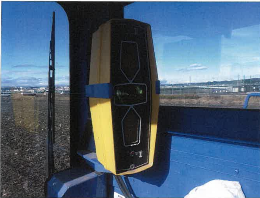
暗渠排水工 富里工区177 吸水渠工 吸水管布設状況(レーザーレ ベル受光器)
