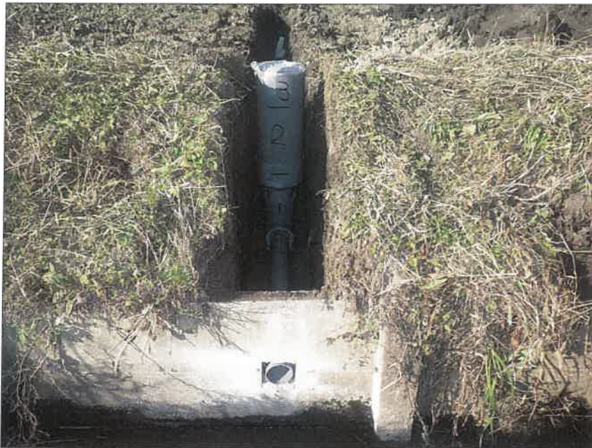
暗渠排水工 富里工区177 水閘工 管(水閘)布設完了
