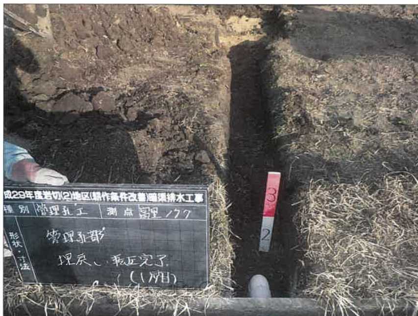
写真区分: 施工状況写真 工種: 暗渠排水工 種別: 富里工区177 細別: 管理孔工 写真タイトル: 管理孔部 埋戻し・転圧完了(1層目)
