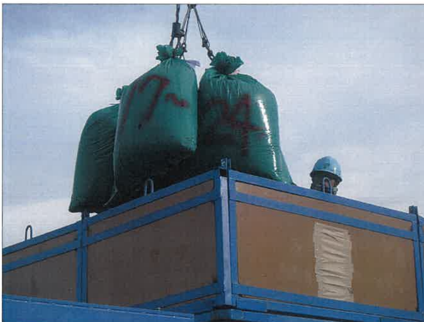
暗渠排水工 富里工区177 吸水渠工 モミガラ積込み状況(17~24袋)
