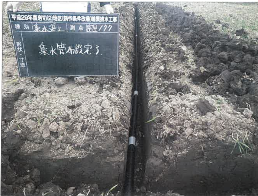
暗渠排水工 富里工区177 集水渠工 集水管布設完了(B~C)
