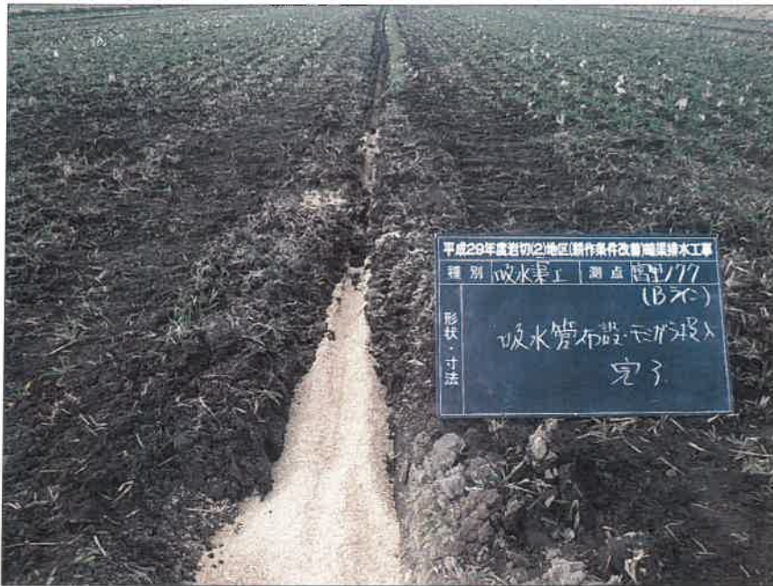
暗渠排水工 富里工区177 吸水渠工 吸水管布設・モミガラ投入完了
