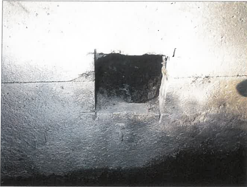
暗渠排水工 富里工区177 水閘工 吐口ハツリ完了
