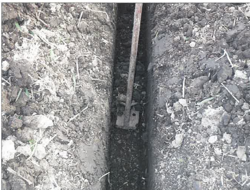
暗渠排水工 富里工区177 集水渠工 人力床均し状況 拡大
