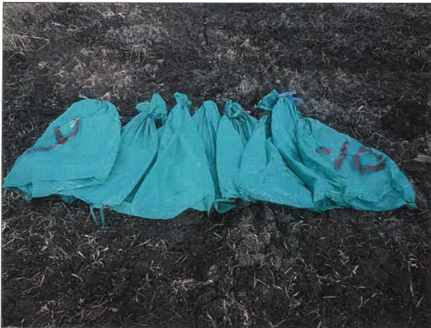
暗渠排水工 富里工区177 吸水渠工 モミガラ空袋確認(9~16袋)
