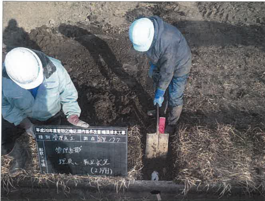
写真区分:施工状況写真 工種:暗渠排水工 種別:富里工区177 細別:管理孔工 写真タイトル:管理孔部 埋戻し・転圧状況(2層目)
