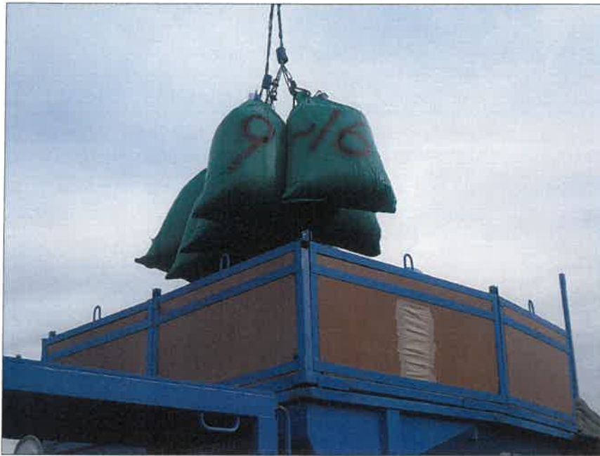
暗渠排水工 富里工区177 吸水渠工 モミガラ積込み状況(9~16袋)
