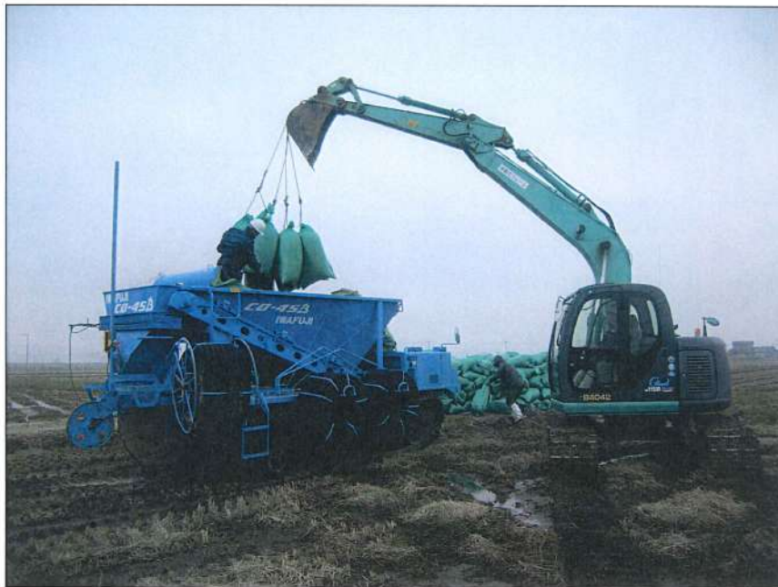
工種：吸水渠工 細別：モミガラ積込み状況
