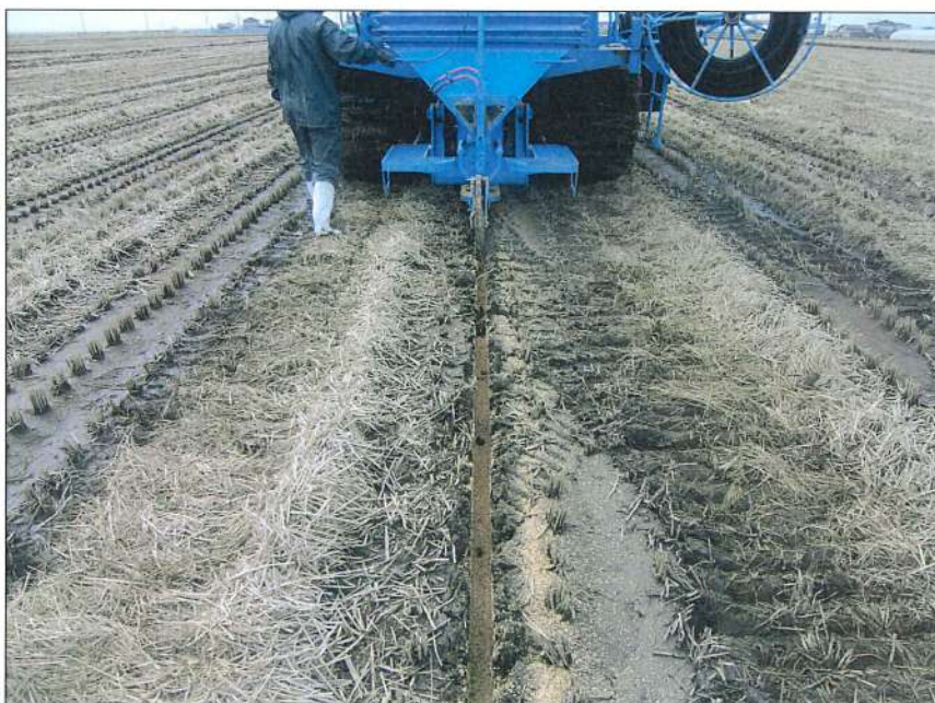
工種：吸水渠工 細別：モミガラ布設状況
