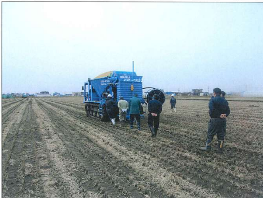
工種：吸水渠工 細別：吸水管布設状況
