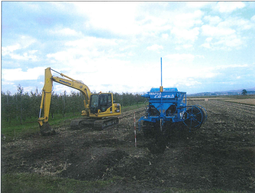
施工状況 吸水管引込状況
