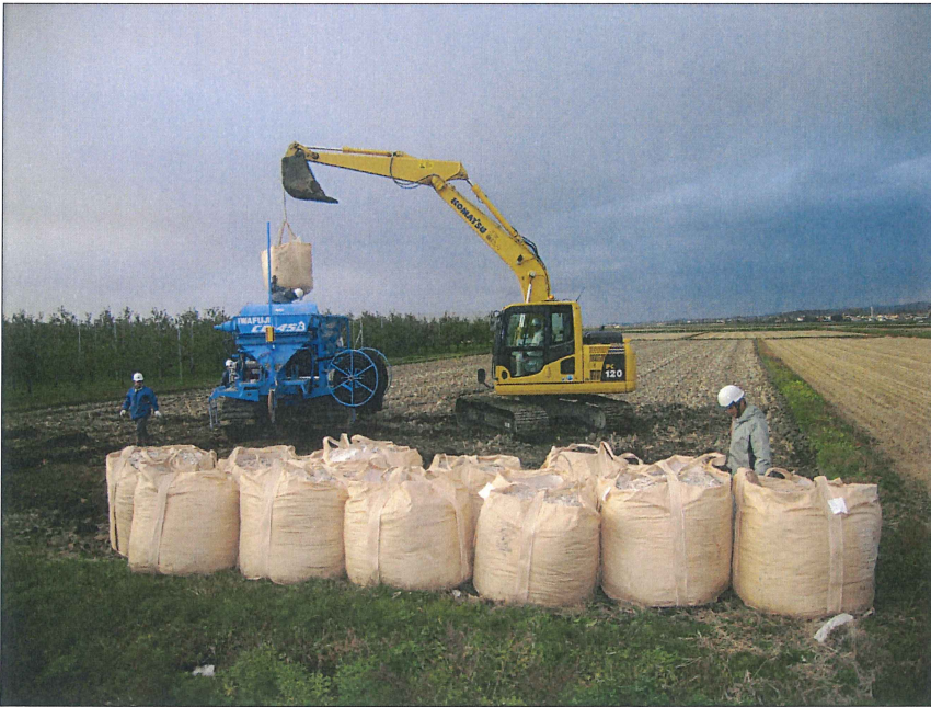
施工状況 ホタテ殻積込状況
