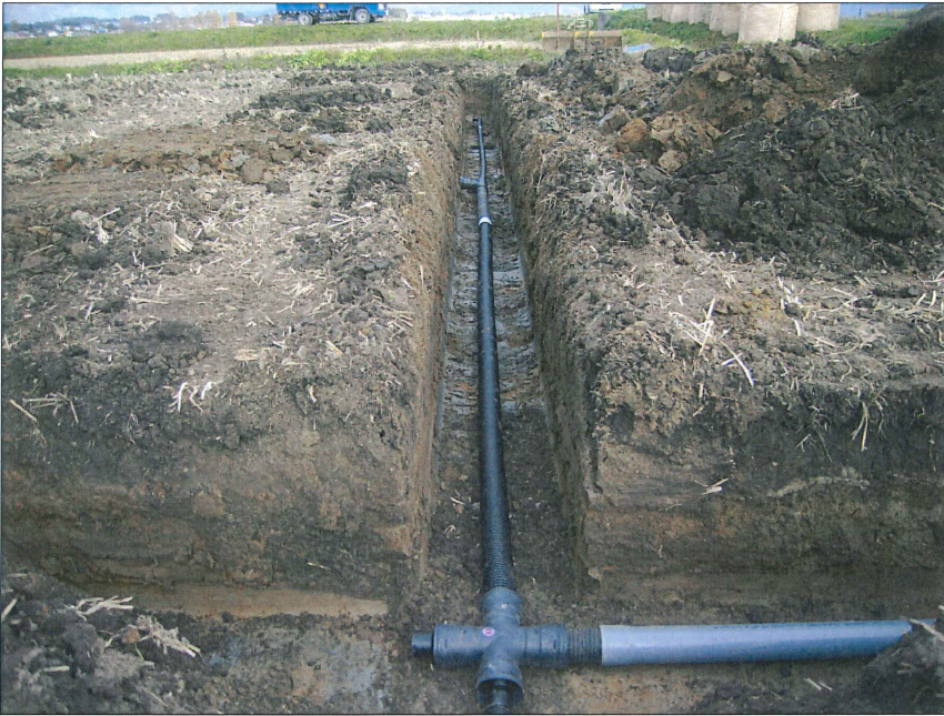
施工状況 集水管布設完了
