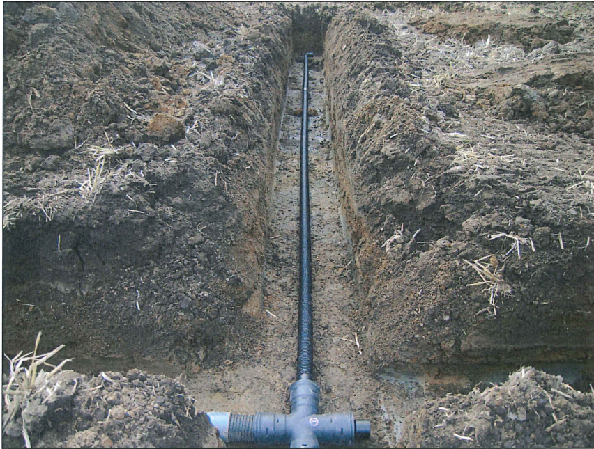
施工状況 集水管布設完了
