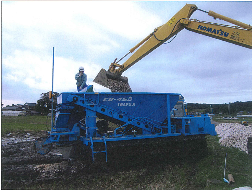
試験施工 リバーズ工法 カキ殻積込状況
