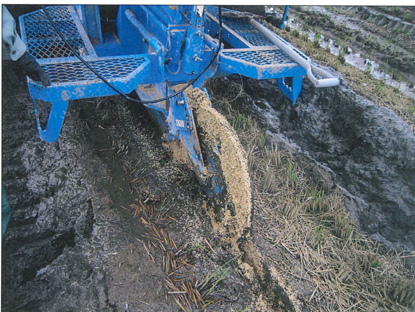
試験施工 補助暗渠工 モミガラ転圧状況
