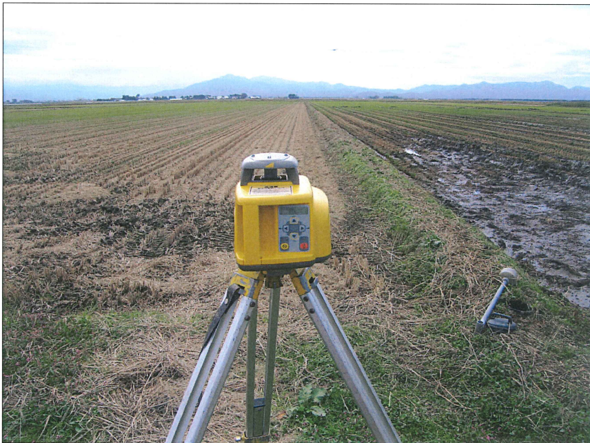
試験施工 リバース工法 レーザーレベル 発光器
