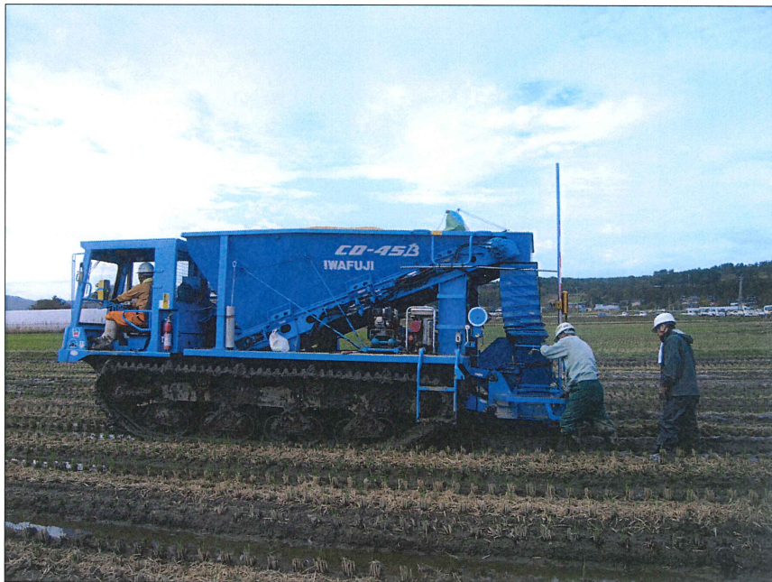
試験施工 補助暗渠工 施工状況
