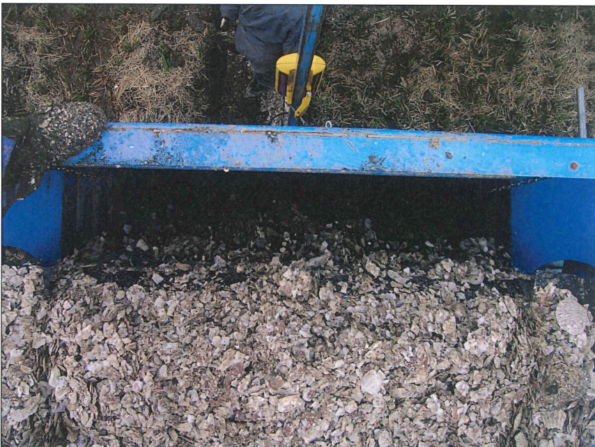
試験施工 リバーズ工法 部分拡大
