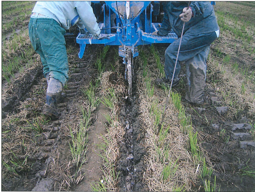
試験施工 リバース工法 カキ殻転圧状況
