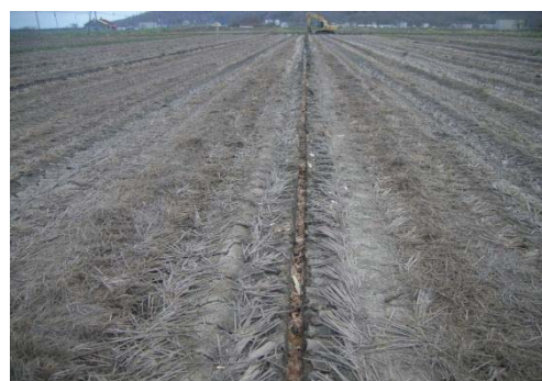
No.5 吸水管、疎水材埋設状況
