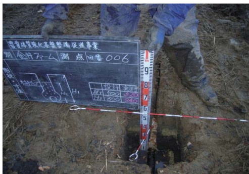
No.5 吸水管、疎水材埋設状況
